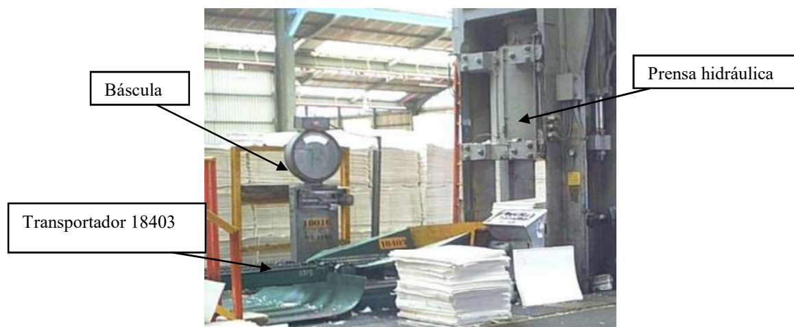
Figura 6. 2 Transportador 18403 y transportador de la prensa hidráulica
