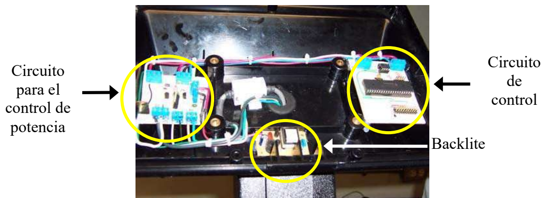
Figura 3. 63 Colocación de los circuitos en el tablero.
