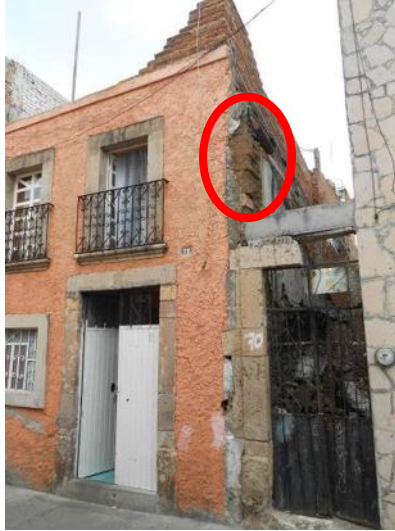
Figura 19. Casa ubicada en Monte de las Cruces donde se observa todavía restos de adobe en su sistema constructivo. Imagen de la autora.
