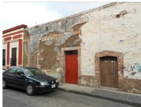
Figura 20. Vivienda ubicada en la calle Granaditas, en el muro de la fachada se ve percibe adobe cómo material de construcción. Imagen de la autora.
