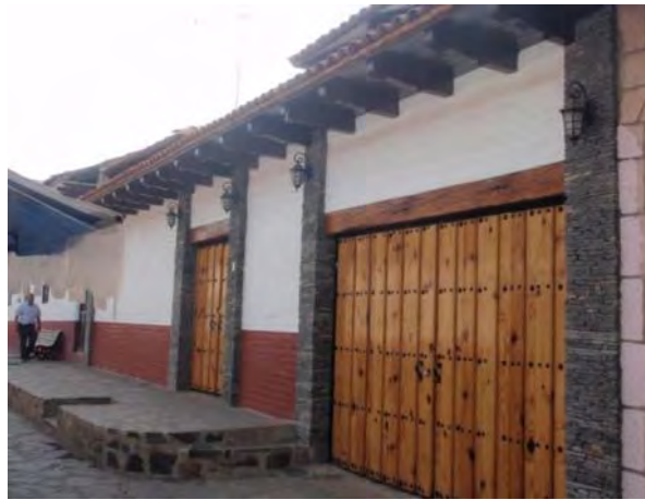
Figura 129. Edificación Actual Contextual en la calle Hidalgo, anteriormente se mostraba como Edificación No contextual . Fuente: Foto tomada por la autora.
