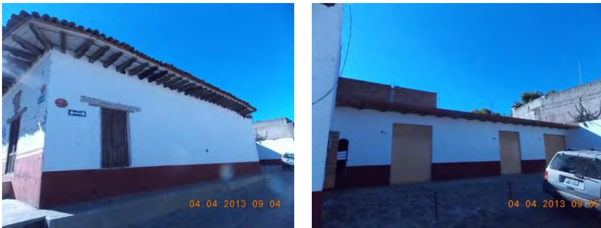
Figura 126. Ejemplo de edificación donde se perdió el alineamiento aproximadamente en el año 2008, para la adecuación de un estacionamiento. Fuente: Foto tomada por la autora.
