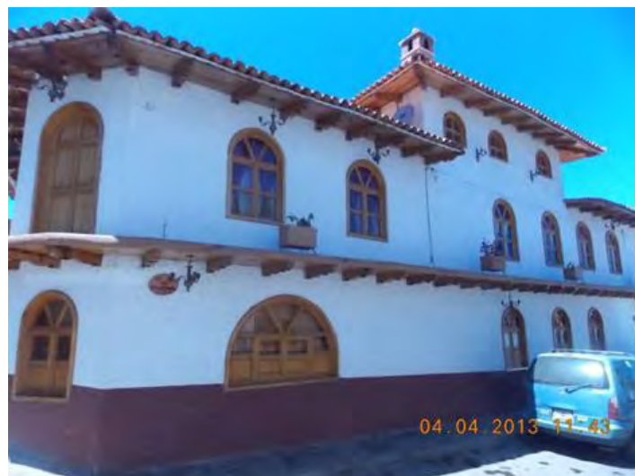
Figura 108. Edificación actual en buen estado de conservación, ejemplo del mayor porcentaje de edificaciones en la zona patrimonial y también en las periferias. Fuente: Foto tomada por la autora.
