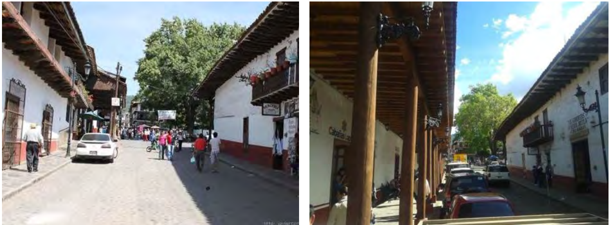
Figura 130. Construcción de la continuación del portal Allende. Fuente: (izquierda) Tomada de http://hotelrealdelasierra.com/galeria [Fecha de consulta: 16 de diciembre de 2012]; (derecha) foto tomada por la autora [2013].
