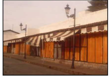
Figura 67. Calle Hidalgo año 2012, la mitad de los locales comerciales se encuentran en desuso. Fuente: Foto tomada por la autora.
