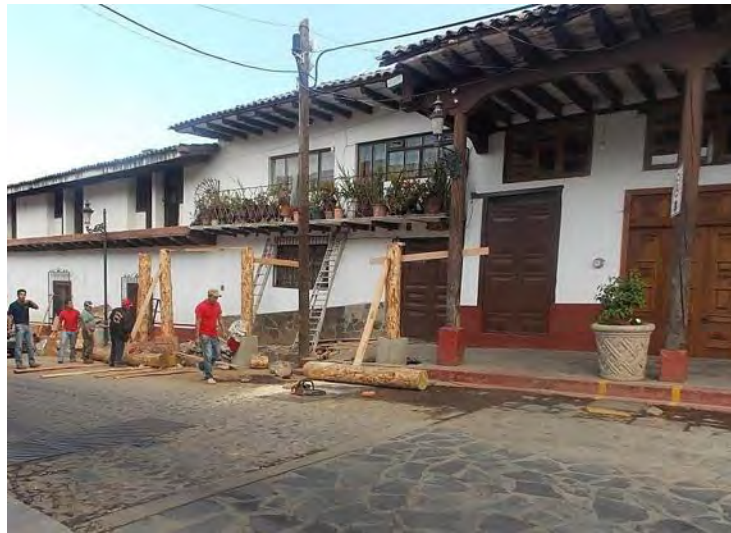
Figura 68. Construcción de la continuación del portal Allende. Fuente: Foto tomada por la autora.
