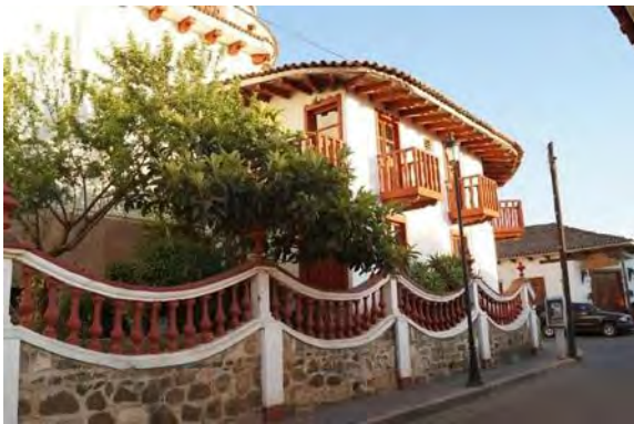
Figura 57. La casa cural, anexo al templo, edificación actual con características armónicas. Fuente: Foto tomada por Josué Tello.
