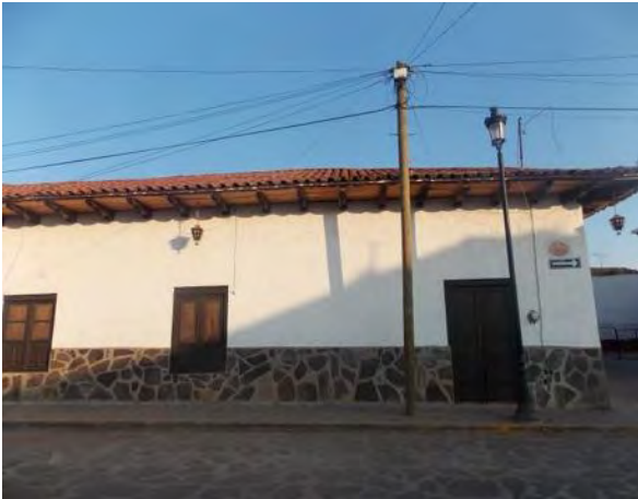
Figura 104. Edificación en buen estado de conservación. Fuente: Foto tomada por la autora.
