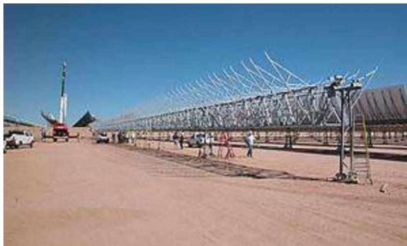
Figura 3.16 Estructura portante de acero
