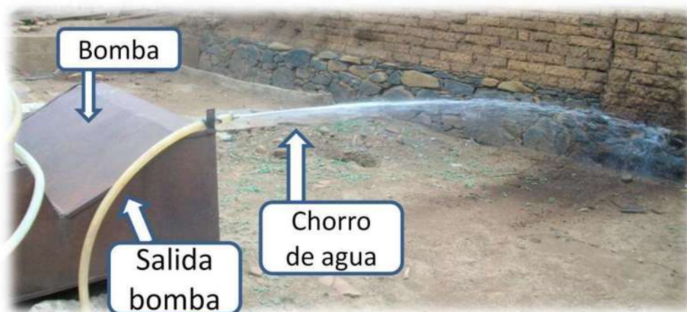
Figura 4.7 Bomba encendida de la primer prueba.
