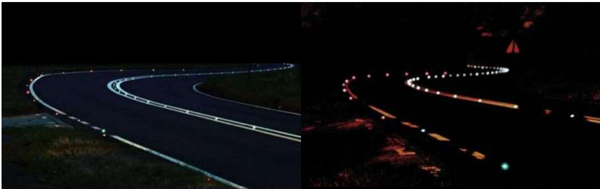
Figura 3.8 Carretera de Inglaterra iluminada por medio de leds.
