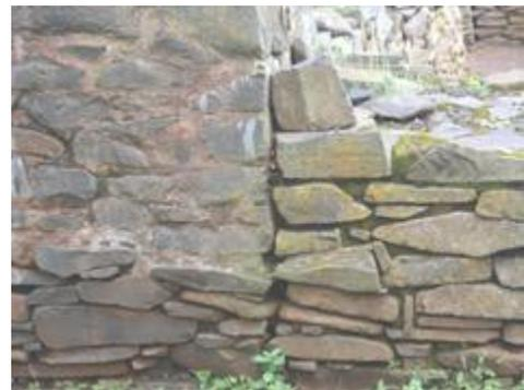
**Fig. 27. Aparejos siguiendo la vertical.** Estructura “B” del sitio arqueológico de las *yácatas*.
