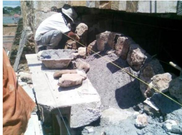
**Fig. 45. Material con características prehispánicas, adecuado a manera de dovela para conformar el sistema de arco, algo que no se había reconocido en esta fábrica. Sacristía, ex convento de Tzintzuntzan.**
