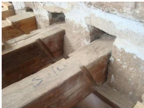
**Fig. 32. Proyección de cargas verticales distribuidas por los arrocabes.** Claustro del ex convento de Tzintzuntzan. Fotografía: R. López, 2010.
