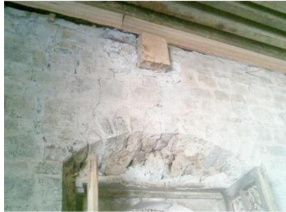
**Fig. 44. Adecuación de material reutilizado en la definición del cerramiento. En esta imagen se aprecia el vestigio (empotramiento) la viga gualdra que contrarrestaba la concentración de cargas de muros divisorios. Sacristía, ex convento de Tzintzuntzan.**
