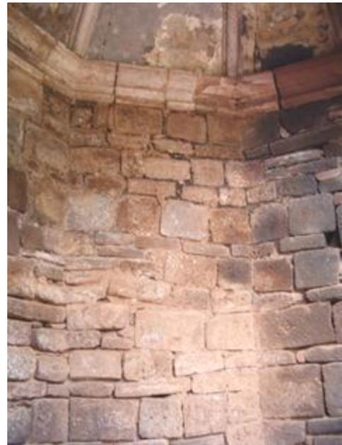
**Fig. 28. Sillares labrados posiblemente a la manera prehispánica.** Capilla abierta, ex convento de Tzintzuntzan.
