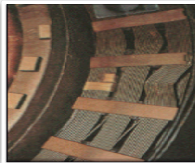
Figura 3.5 Deformación radial.
