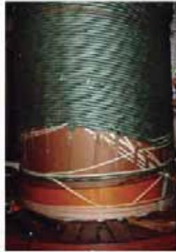
FIGURA 2.2: Movimiento Axial y Radial en bobinas de transformador
