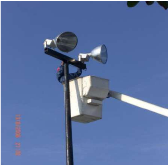
Figura 2.3- Personal trabajando en el canasto de la grúa.
