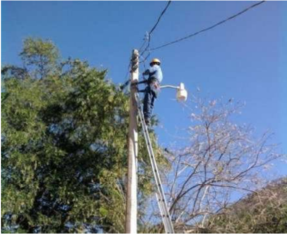
Figura 2.2- Utilizando escalera para la reparación de la luminaria.
