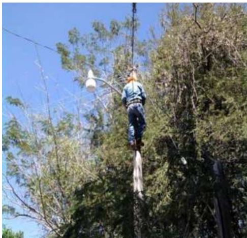
Figura 2.1- Utilización de maneas para escalar el poste.
