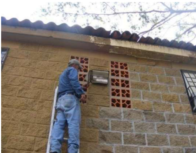
Figura 3.6.- Inspección de luminarias
