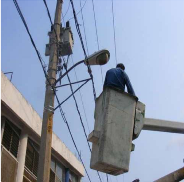
Figura 3.2- Revisión de una luminaria tipo OB-15.
