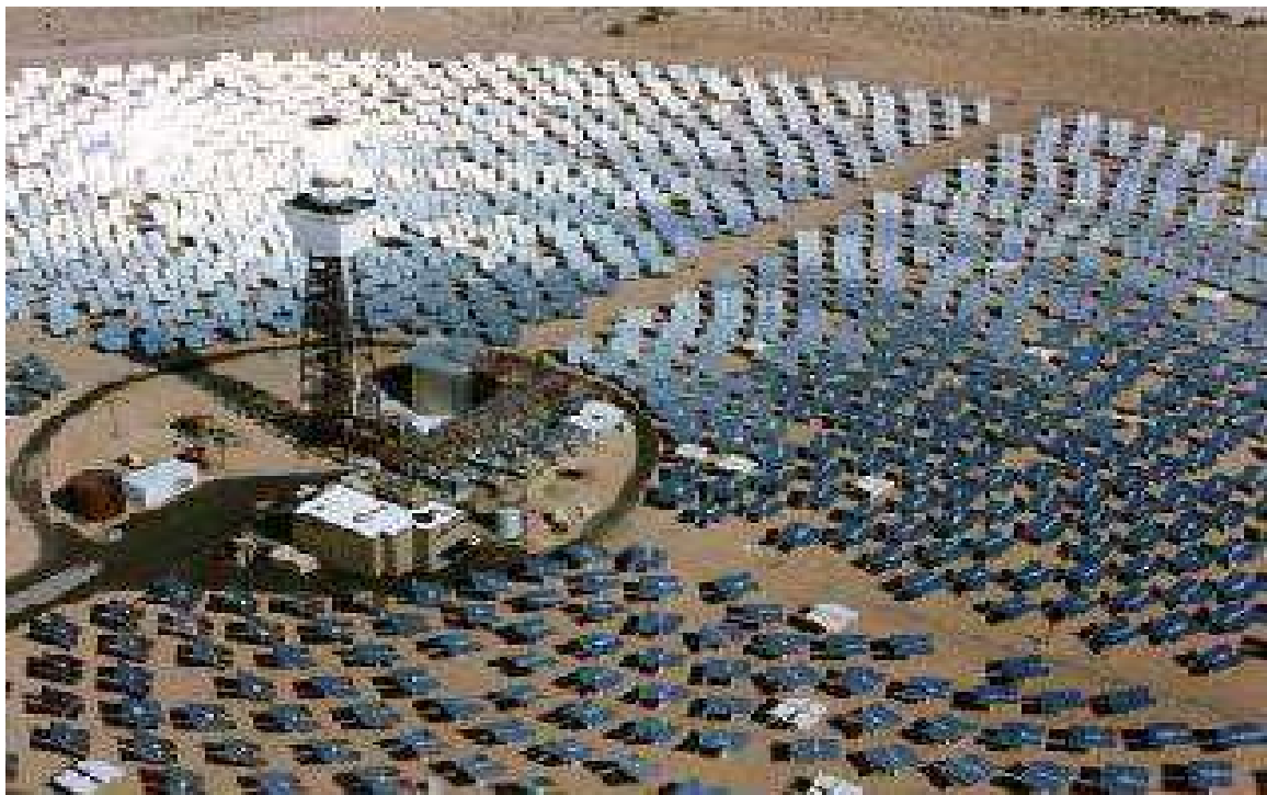
Figura 2.8 Sistema de receptor central
