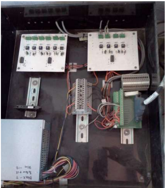
Figura 4.11 Montaje del Hardware.
