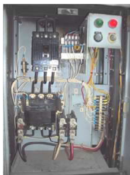
Figura 2.3 Arrancador a Tensión Plena.
