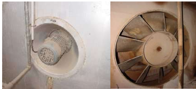
Figura 3.1 Motor utilizado para el flujo de aire.
