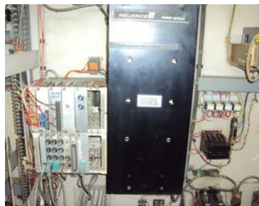
Figura 2.5 Control de un Drive de CA.
