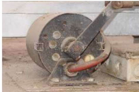
Figura 3.3 Motor para control de ventilas.
