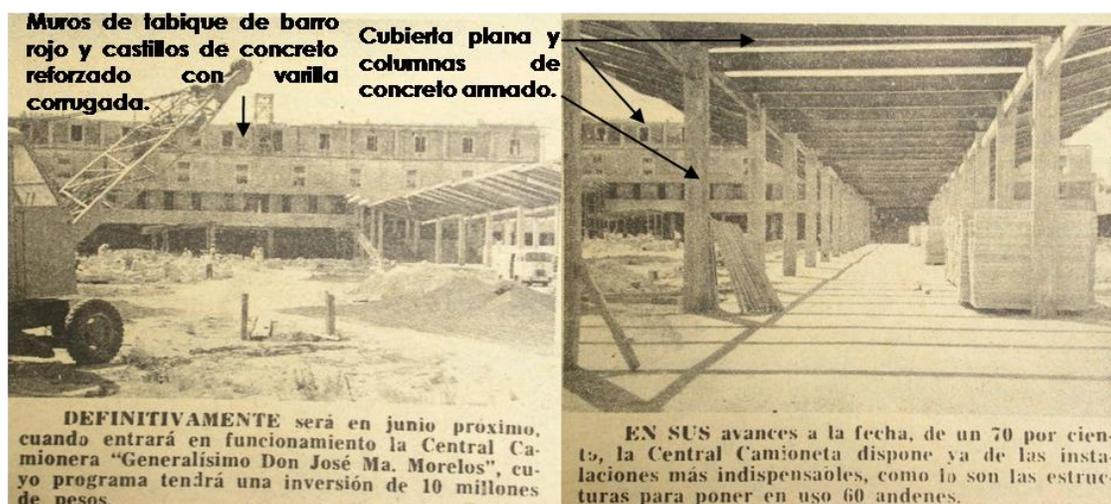
Imagen 104. Fotos del proceso de construcción de la Estación Central de Autobuses "Generalísimo Morelos". Donde se observa parte de los sistemas constructivos empleados (Marzo de 1967), Fuente: "Definitivo. En la primera quincena de junio entra en servicio la central camionera local", *La voz de Michoacán*, Morelia, Mich., 13 de Marzo de 1971, Año XXIII Núm. 5944, pp. 1, 12. Adecuación: EGV.
