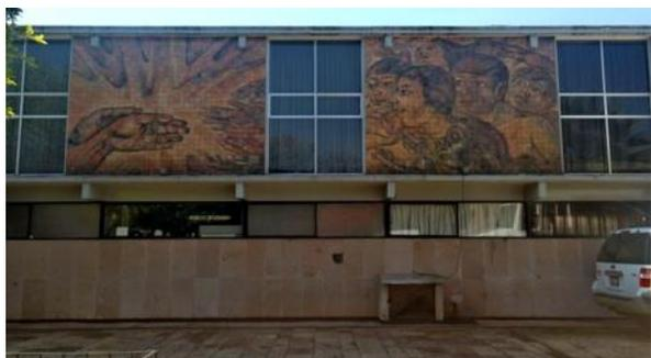
Imagen 66. Fachada principal de la Escuela Normal Urbana Federal, su sistema constructivo: muros de tabiques rojos recubiertos con cantería laminada, columnas, traveses y losas de concreto armado, ventanas de vidrio con herrería y murales con piezas de azulejo. Foto EGV.
