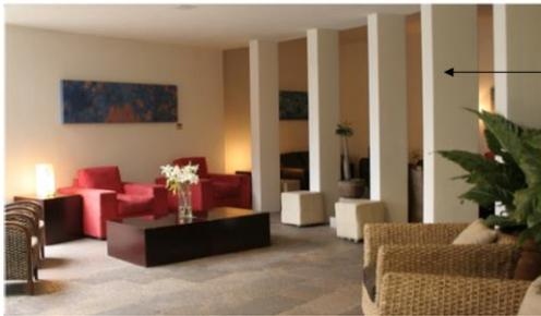
Columnas exentas, parte de la estructura que reciben la losa también de concreto armado.
