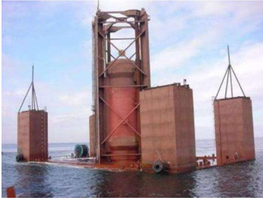
**Figura 2.8 Aplicación real del columpio de olas de Arquímedes.**
