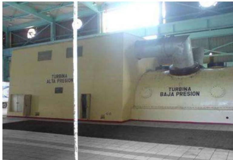
Figura 5.5 Turbinas de alta y baja presión.
