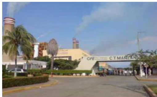
Figura 5.1 Central Termoeléctrica Manzanillo.
