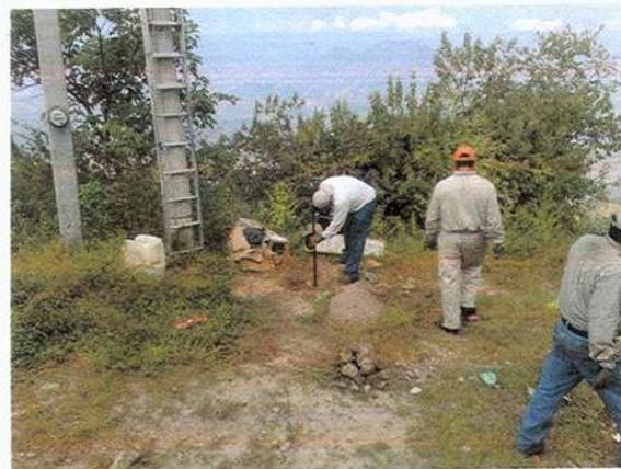
Instalación de electrodo para tierra física
