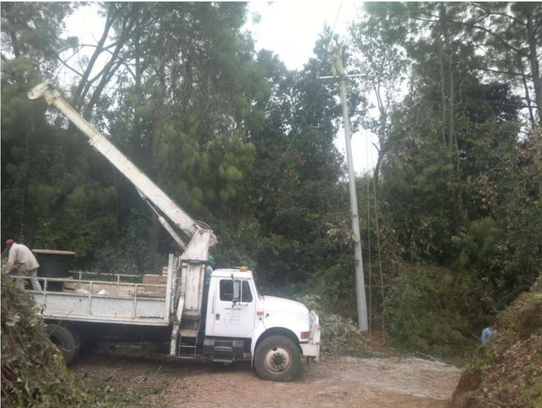
Fotografía de obra en proceso de construcción.
