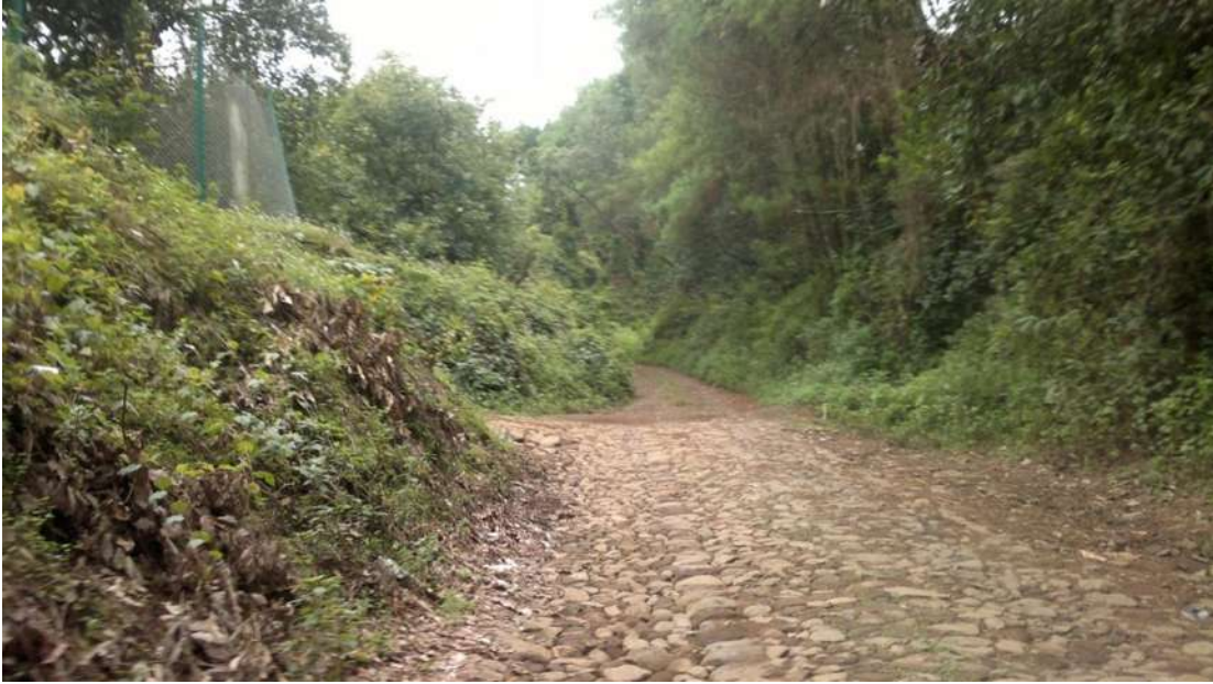
Fotografía de proyecto antes de iniciar obra.
