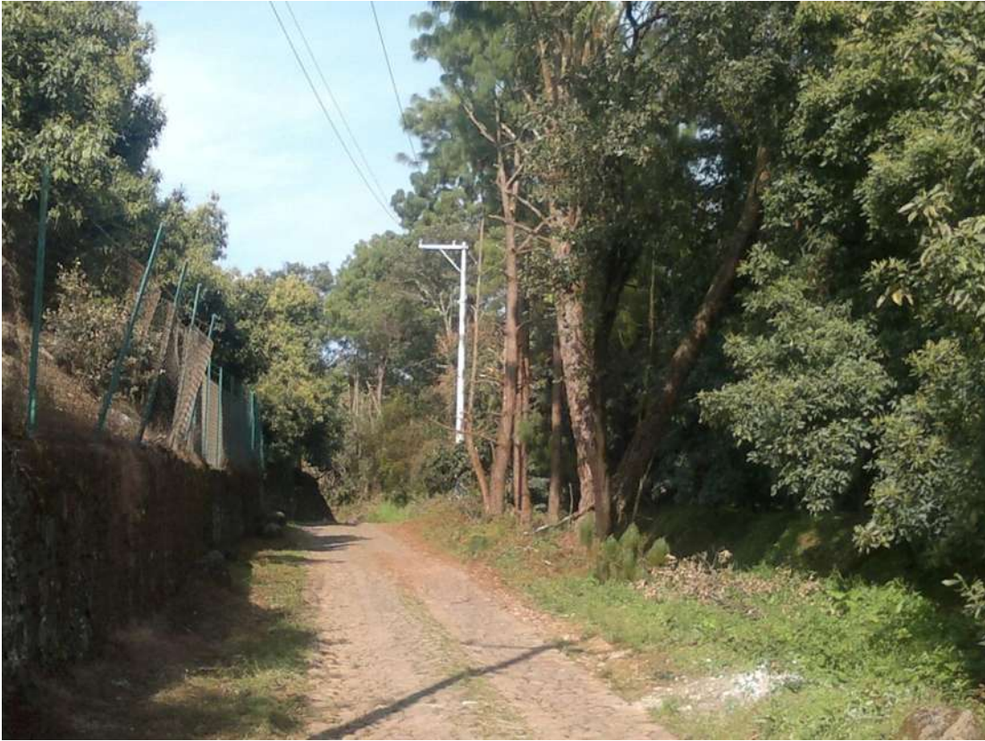
Fotografía de obra terminada.
