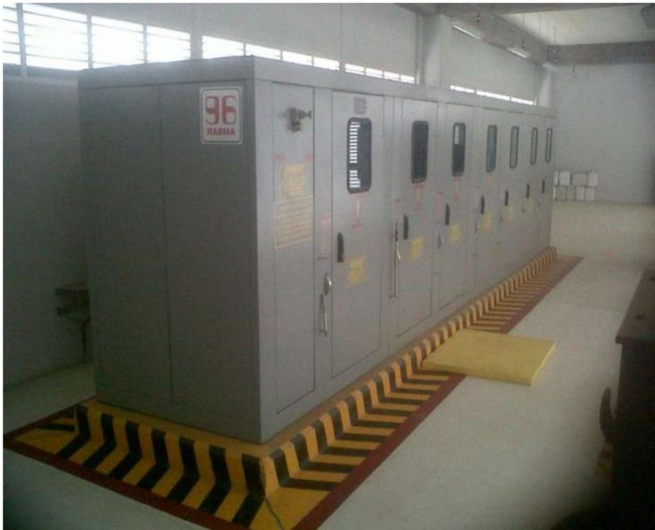
**Figura 4.3 Subestación eléctrica tipo compacta 13200 Volts**
