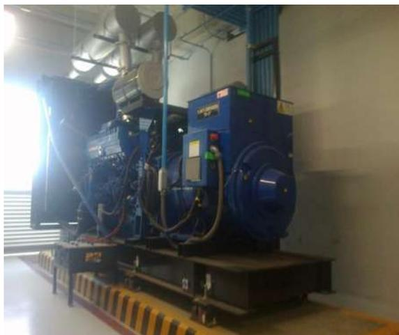
**Figura 4.1 Planta de emergencia 1000 KW**
