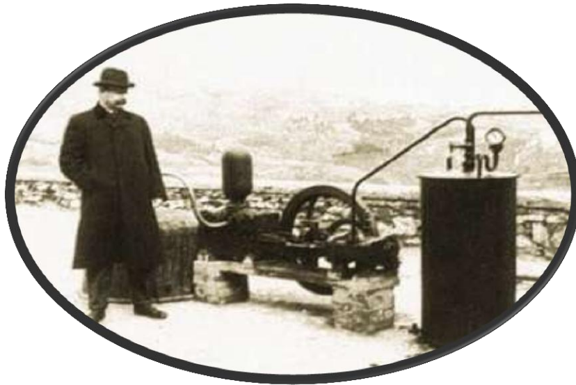
Figura 2.2 Máquina usada en Larderello en 1904 en la primera experiencia de generación de energía eléctrica mediante vapor geotérmico, con su inventor, el Príncipe Piero Ginori Conti.
