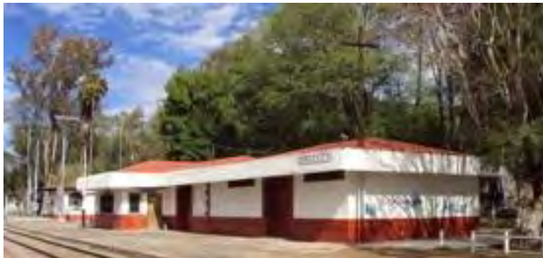
FIGURA 22. Fotografía actual, en donde se observa la cubierta modificada. Imágenes tomadas del Catálogo Nacional de Estaciones ferroviarias de CONACULTA.
