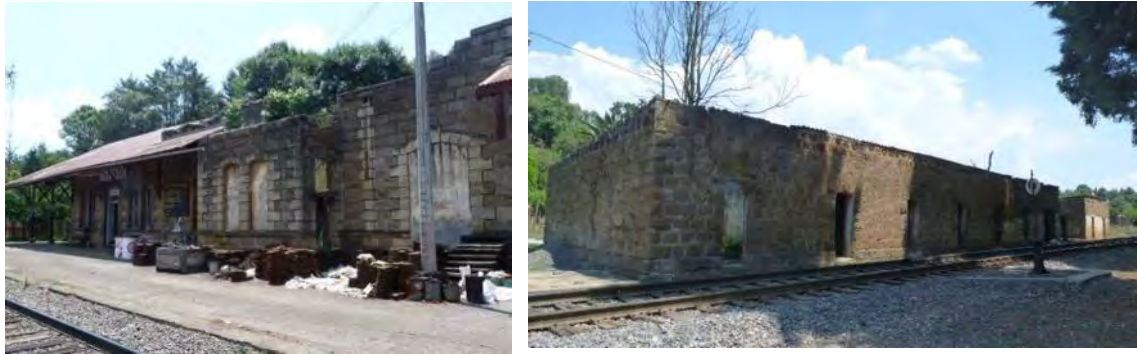
FIGURA 29 y 30. Fotografías donde se observan las edificaciones complementarias a la estación y el estado de conservación de la Estación Ajuno. A la izquierda, la parte colapsada donde se ubicó el hospedaje para viajeros, en la fotografía se aprecia la presencia de vegetación de esta área y a la derecha el campamento de trabajadores de vía y al fondo el campamento del Mayordomo. Fotografías: AEZL.
