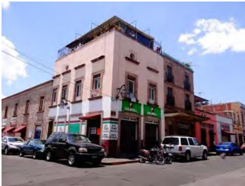
Imagen-IV.7. Inmueble Aprovechado en su Azotea. Polígono San Francisco-Jardín Villalongín
