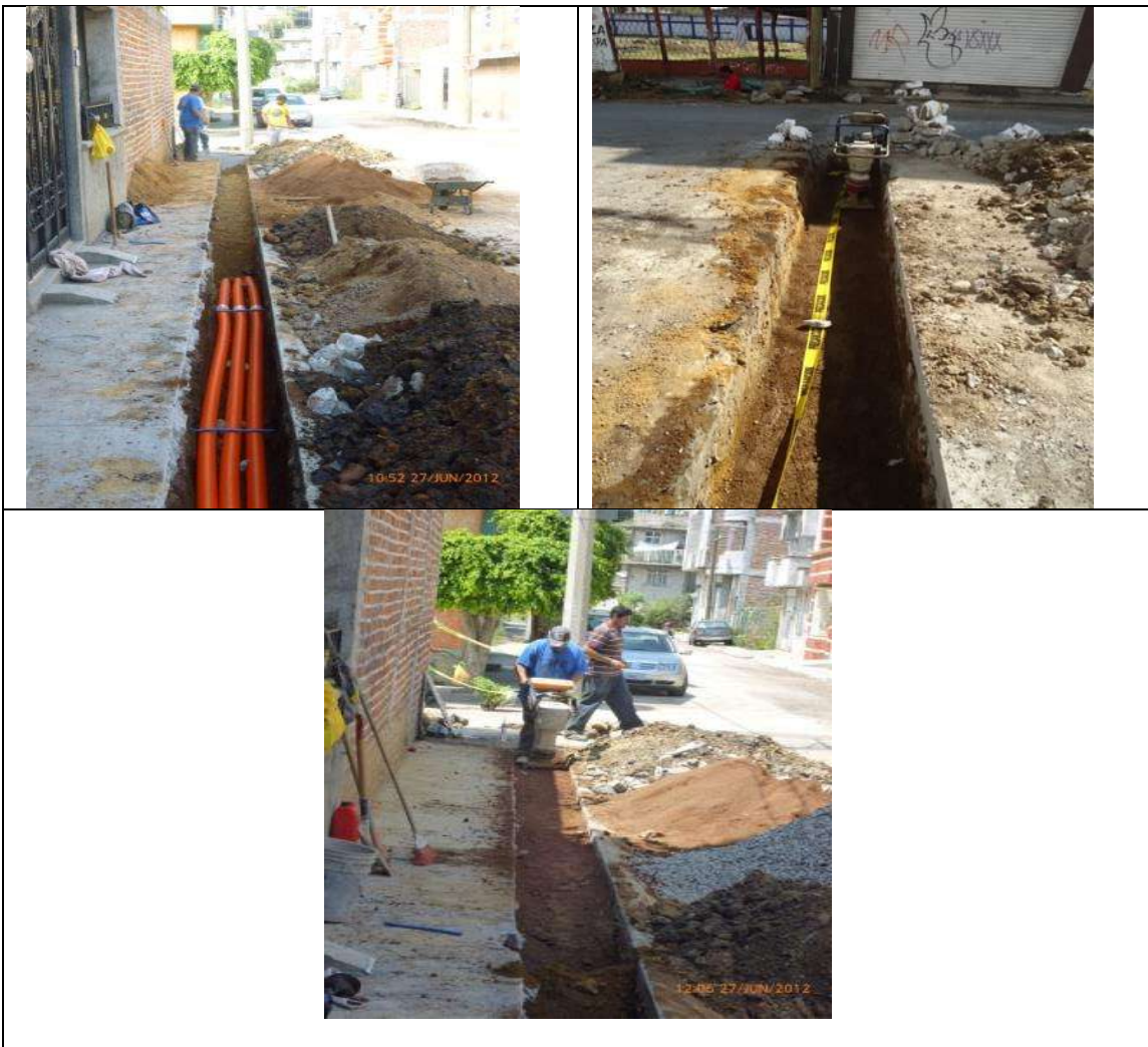
Figura 56 Cubriendo tubo PAD, colocación de Cinta de Advertencia y Compactación
