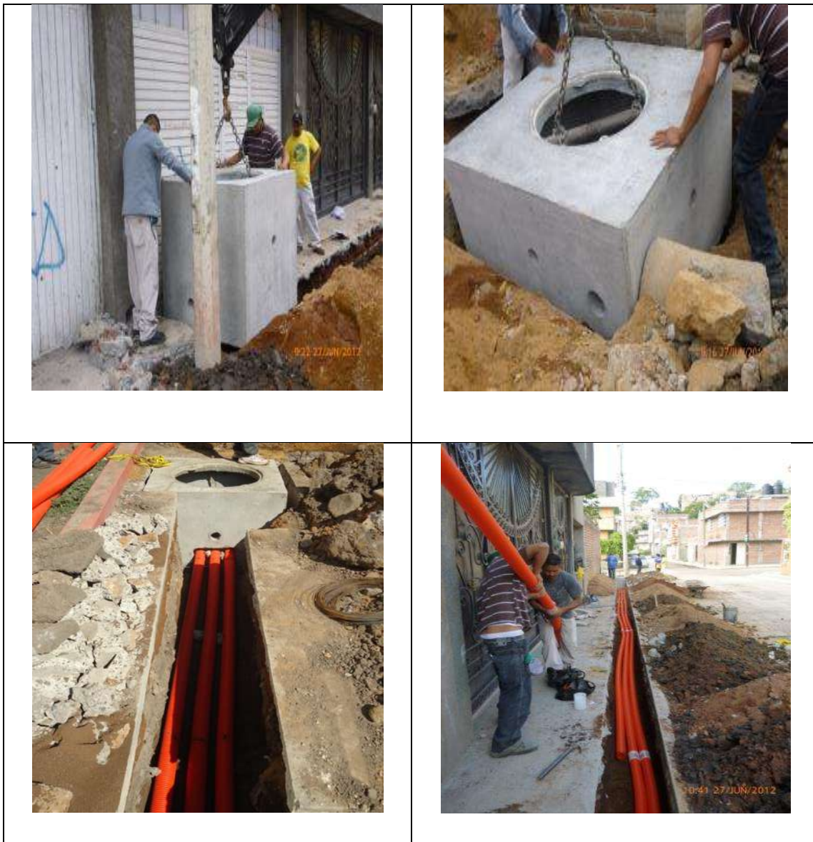
Figura 55 Colocación y Nivelado de Registro de Media Tensión y colocación de tubo PAD
