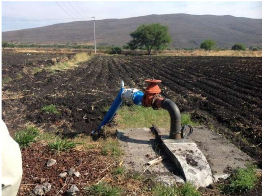
**Figura 6** Equipo de bombeo tipo sumergible del pozo de riego Cañón de Valencia de Cerano Gto.
