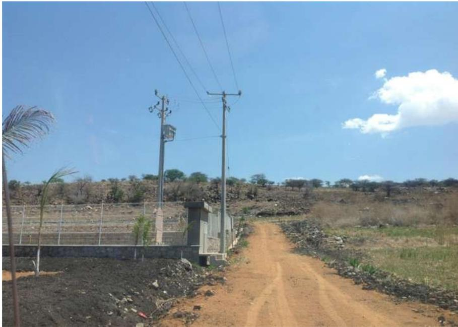
**Figura 12** Subestación tipo poste de 75 KVA en instalaciones de Multigranos del Bajío ubicadas en Isaac Arriaga, Michoacán.
