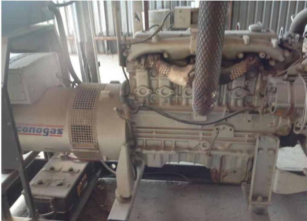
Figura 20 Generador de combustión interna con generador eléctrico acoplado y alimentado con metano
