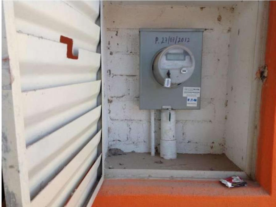
**Figura 15** Medición auto-contenida de la Subestación tipo pedestal de 75 KVA de las instalaciones de Multigranos Del Bajío ubicadas en carretera La Herradura en Puruándiro Michoacán.
