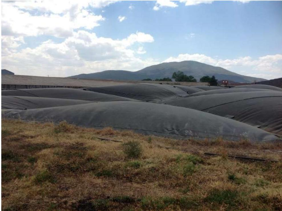
**Figura 17 Biodigestor ubicada en granja de cerdos de Porcicultura Integral AZ en Janamutato Michoacán.**
