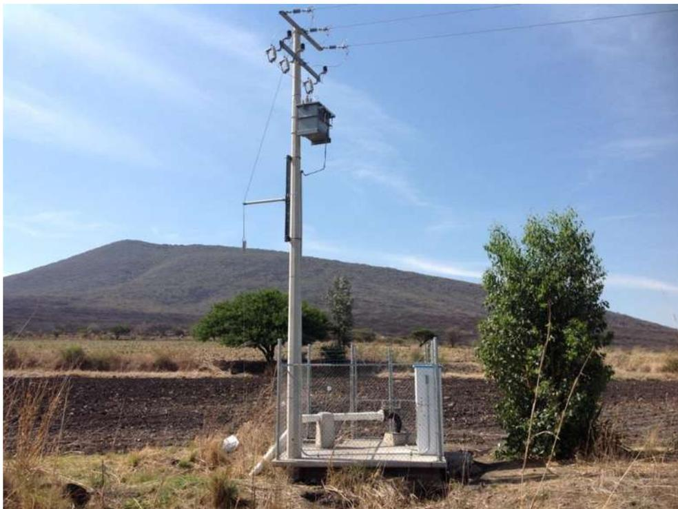
**Figura 8 Cárcamo de bombeo Monarrez con Subestación tipo poste de 30 kva 13200-440/254 Volts**
