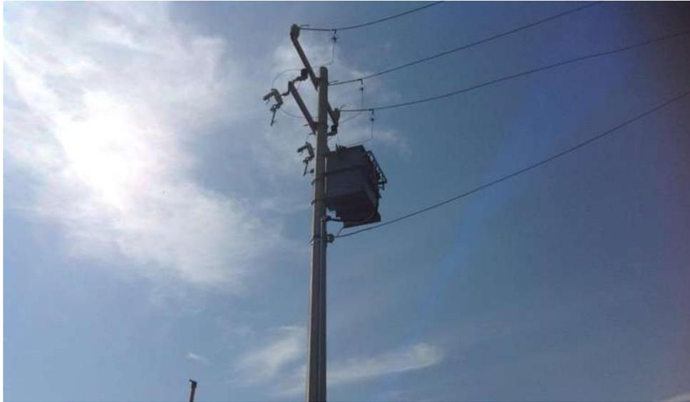
**Figura 7 Subestación tipo poste de 75 Kva 13200-440/254 volts para pozo Cañón de Valencia**
