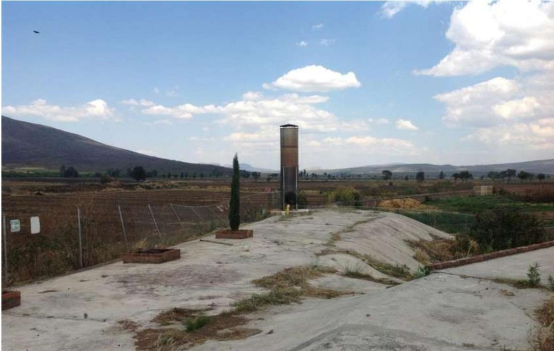
**Figura 18** Incinerador de metano en granja Porcicultura Integral AZ ubicada en Janamutato Michoacán.
