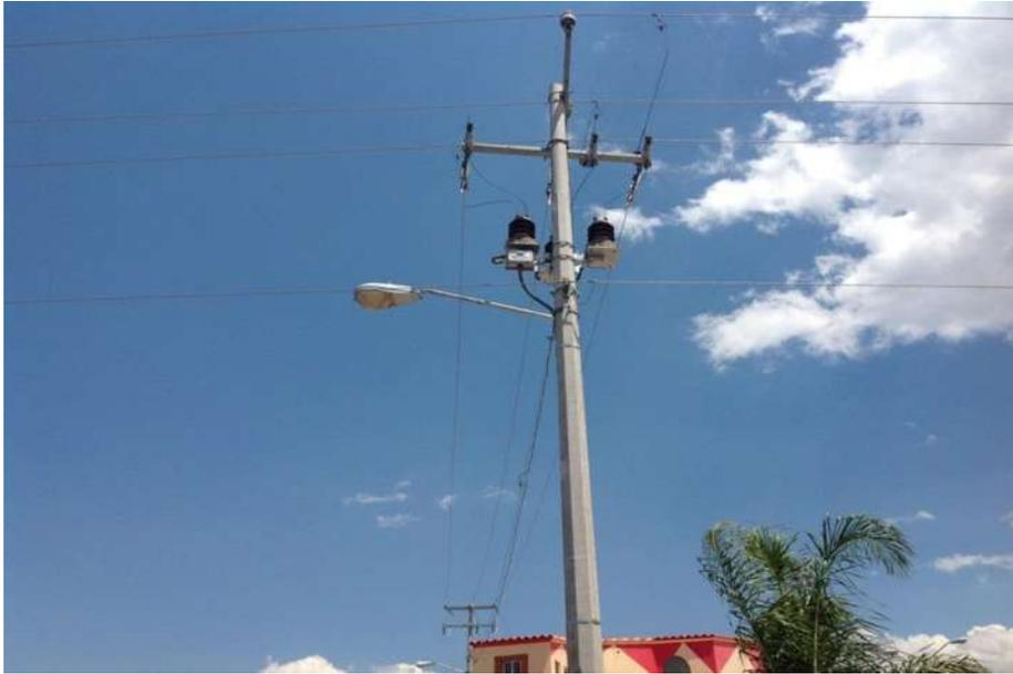
**Figura 11** Equipo de medición Compacta en Media Tensión
