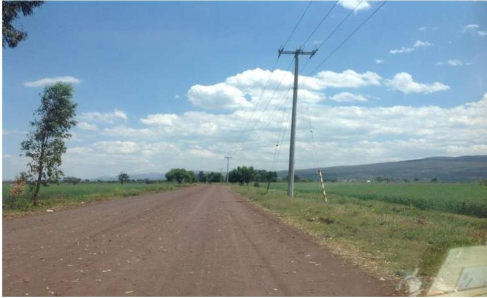
**Figura 5** Línea de media tensión 3F-4H acsr 1/0 para alimentar subestación pozo majaditas
