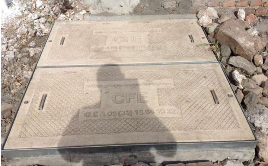
Figura 23 Registro con tapa cuadrada 1.5x1.5x1.5 metros, para alojar los derivadores de media tensión instalado en Agropecuaria Kamanry en Huandacareo Michoacán.
