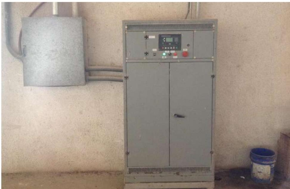
Figura 21 Tablero de transferencia automática que conecta la energía generada por el generador de biogás y algunas cargas del molino de harinas
