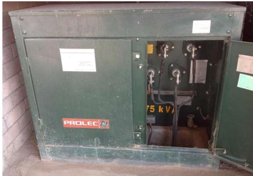
**Figura 14** Subestación tipo pedestal de 75 KVA para alimentar instalaciones de Multigranos Del Bajío ubicadas en carretera La Herradura en Puruándiro Michoacán.
