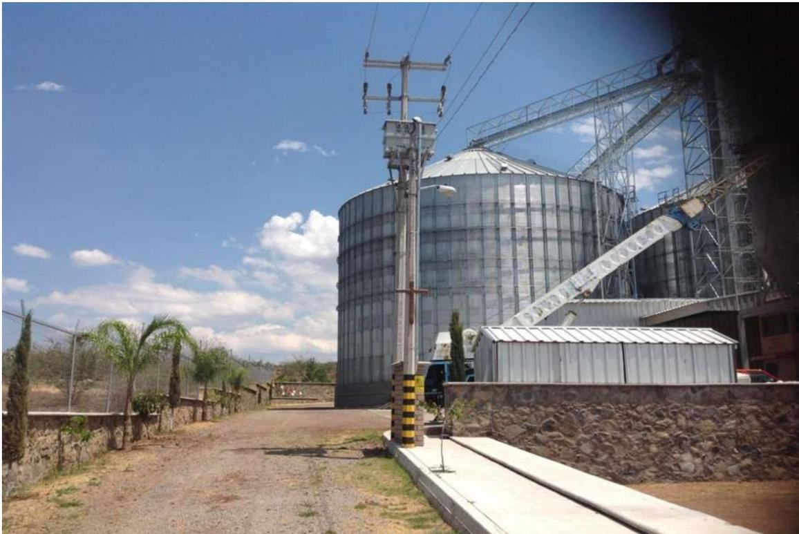
**Figura 10 Subestación tipo parrilla de 225 Kva y medición compacta en media tensión en instalaciones de Multigranos del Bajío ubicadas en San Martín Michoacán**
