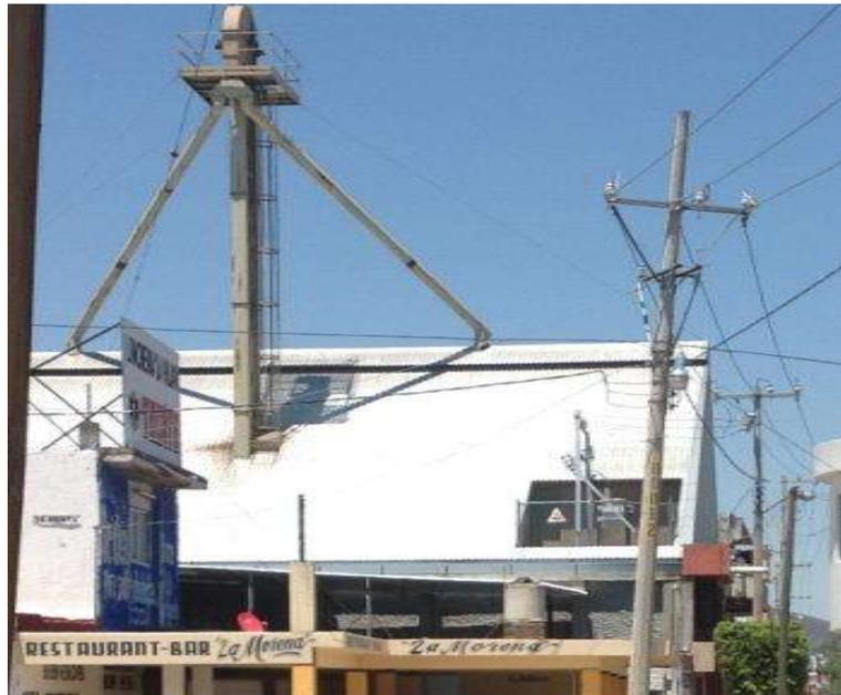
**Figura 16** Subestación tipo azotea de 75 KVA para alimentar instalaciones de Multigranos Del Bajío ubicada en cruce 4 caminos en Puruándiro Michoacán.
