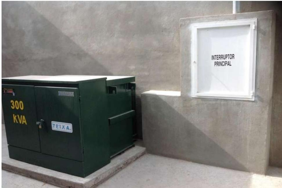
**Figura 25** Subestación tipo pedestal de 13200-440/254 volts para alimentar instalaciones de planta peletizadora de Agropecuaria Kamry de Huandacareo Michoacán.
