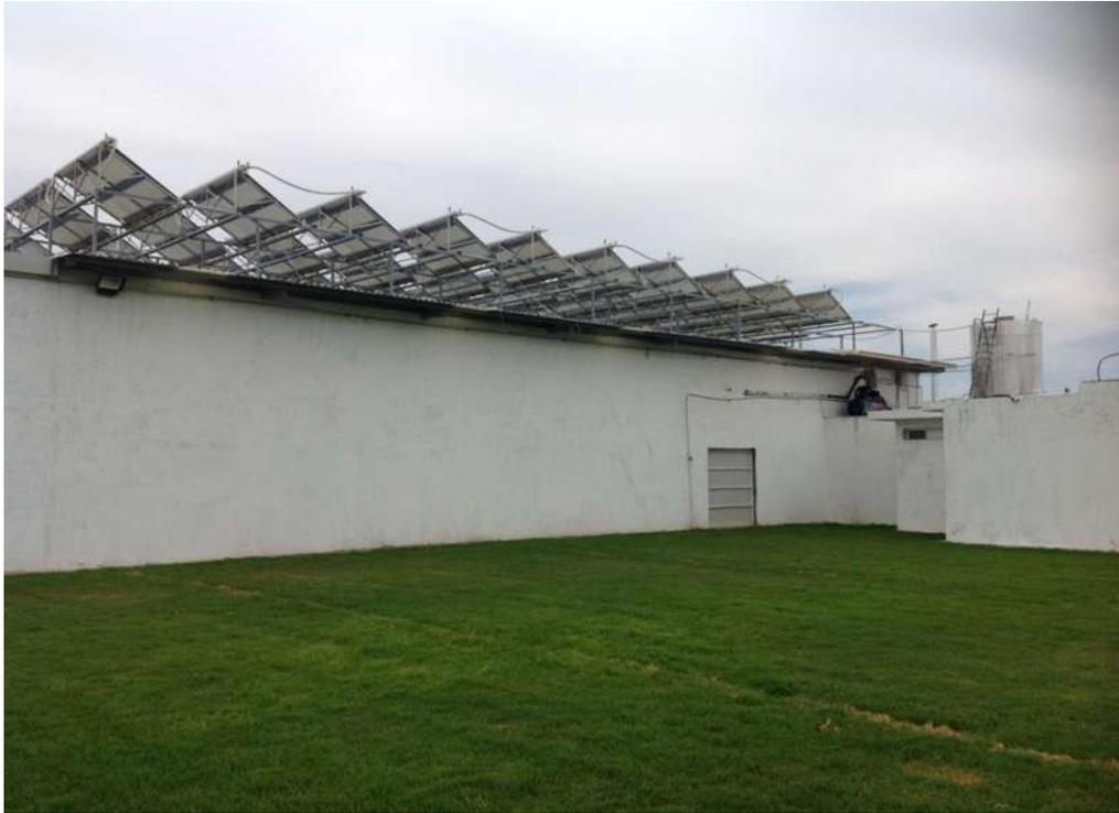
**Figura 33** Calentadores solares que calientan el agua que se usara en el escalpado o pelado del animal, la temperatura del agua en días muy soleados no es necesario usar vapor para calentarla. De esta manera se apoya la ecología evitando quemar combustible, también el agua de desecho se trata y se utiliza para regar los jardines como el que se ilustra en la fotografía.
