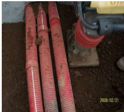
Figura 19 Compactando con Bailarina al Exterior de Registro.
