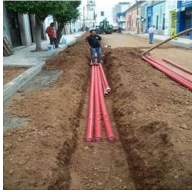
Figura 12 Ductos para Línea Media Tensión
