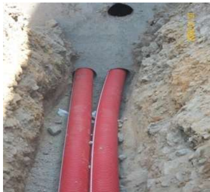
Figura 22 Colocación de Ductos de Baja Tensión.
