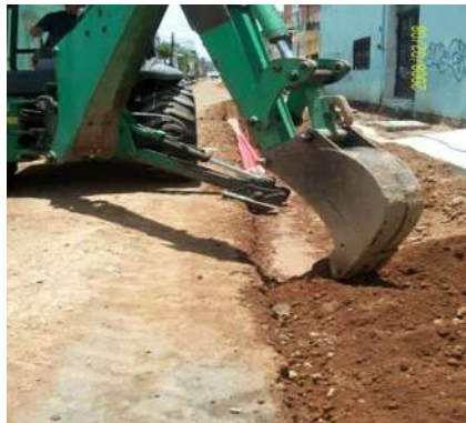
Figura 16 Agregando Materiales con Medios Mecánicos.
