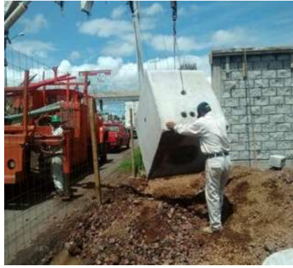
Figura 10 Colocación de Registros de Media Tensión
