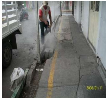
Figura 31 Ancla Armada y registro para alumbrado
