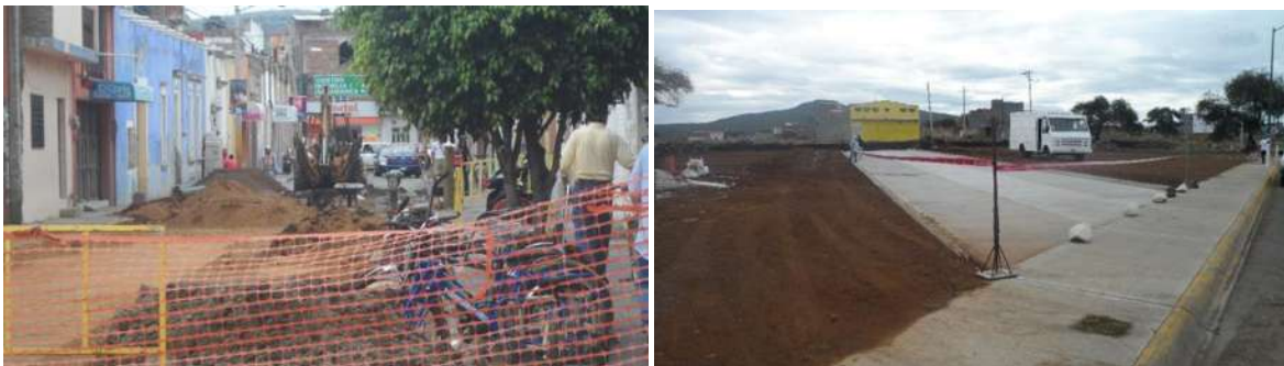
Figura 8 Instalando Señalamientos y Protecciones
