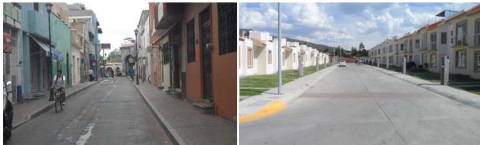
Figura 3 Imagen Urbana de Instalaciones subterráneas fraccionamiento nuevo 1
