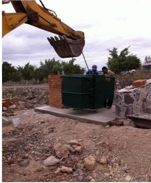
Figura 34 Colocación de Transformador por medios mecánicos
