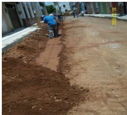
Figura 17 Compactando la Última Capa de Material.
