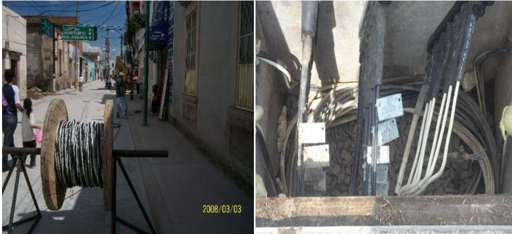
Figura 40 Cableado e identificación de Acometidas
