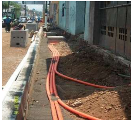
Figura 24 Tirado de Ductos de Acometida.
