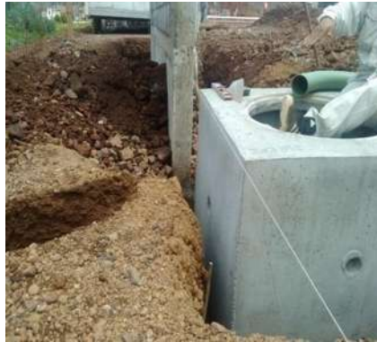
Figura 11 Nivelado de Registro
