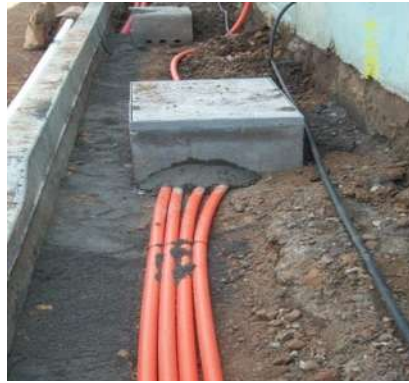
Figura 26 Sellado con Concreto por el Exterior del Registro.
