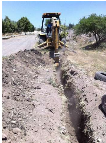
Figura 9 Excavación de la Zanja.
