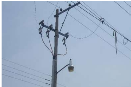
Figura 43 Transición de Línea Aérea a Subterránea
