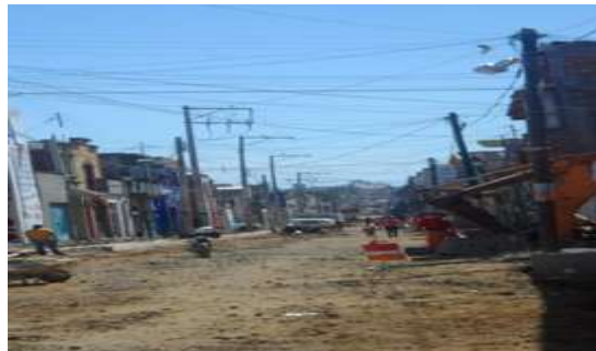
Figura 1 Imagen Urbana de Instalaciones Aéreas de un Centro Histórico
