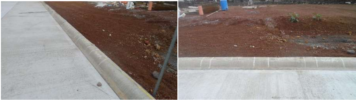
Figura 7 Trazo y Marcado de Componentes de la Instalación
