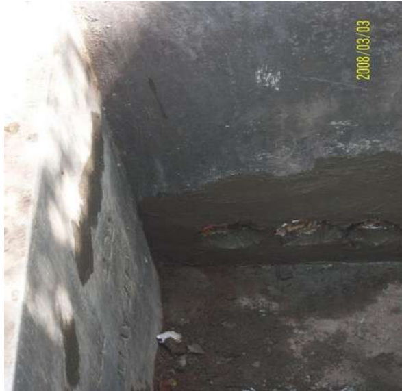
Figura 28 Abocinado de Ductos Dentro del Registro
