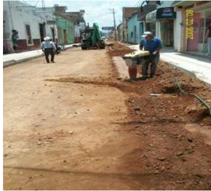
Figura 15 Compactando Material de Relleno con Bailarina.
