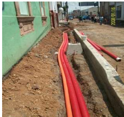
Figura 29 Base tronco piramidal para luminaria
