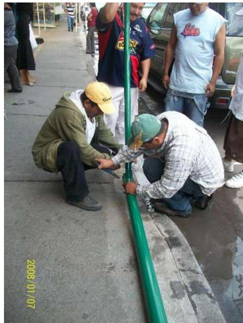
Figura 42 Armado de Luminaria
