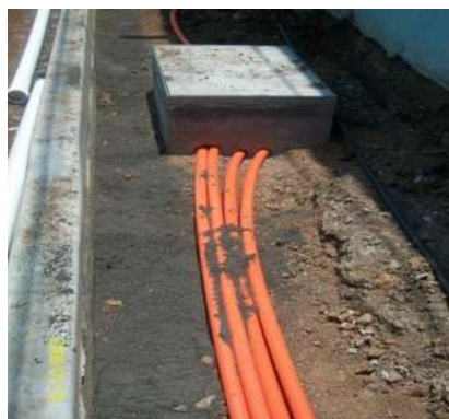
Figura 25 Orden en Las Acometidas Saliedo de los Registros
