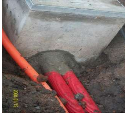
Figura 23 Sellado de Ductos de Baja Tensión en el Exterior.
