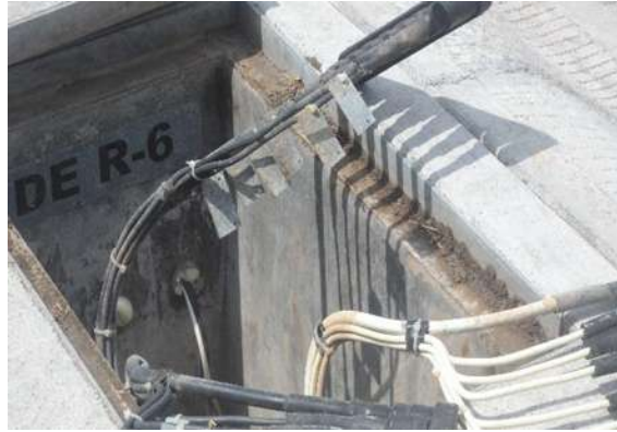
Figura 36 Identificación de registro Baja Tensión
