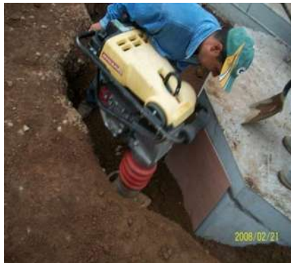
Figura 20 Compactando con Bailarina Pozo de Visita Tipo X.
