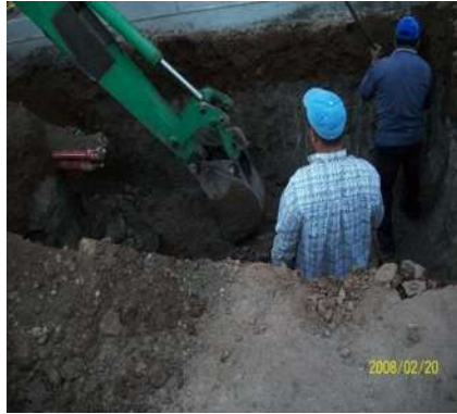
Figura 18 Excavación Por Medios Mecánicos.
