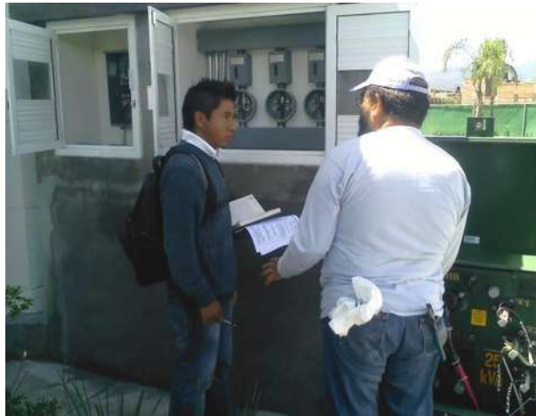
Figura 27 Personal de la unidad de verificación corroborando lo que marcaban los planos e investigando la concentración general de medidores una base 7X200 para el súper y 3 bases 4X100 para los 3 departamentos ubicados en la parte alta de súper de abarrotes 7 big das
