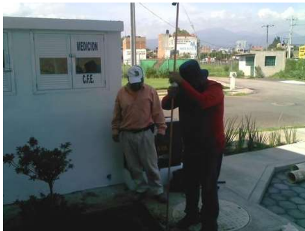
Figura 28 Vista donde se instalan las varillas para la malla de tierras pedidas por la unidad de verificación de instalaciones eléctricas.
