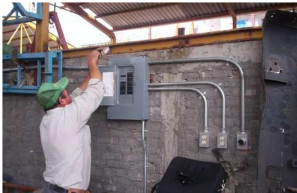
Figura 33 Personal Instalando un tablero de 20 circuitos derivado del interruptor principal de 3X125 amperes que tenían para todo el taller
