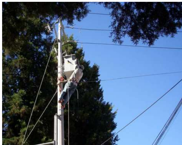
Figura 13 Vista del liniero terminando de Instalar el transformador y vestir el poste en la Escuela Secundaria Ignacio Manuel Altamirano en la población de Zacapu Michoacán
