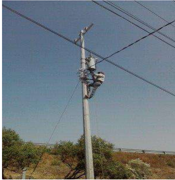
Figura 23 Liniero Instalando el transformador monofasico en el poste que exprofeso C.F.E. nos pido intercalar ya que ellos moverían sus líneas a este en el momento de energizar el circuito de baja tensión.
