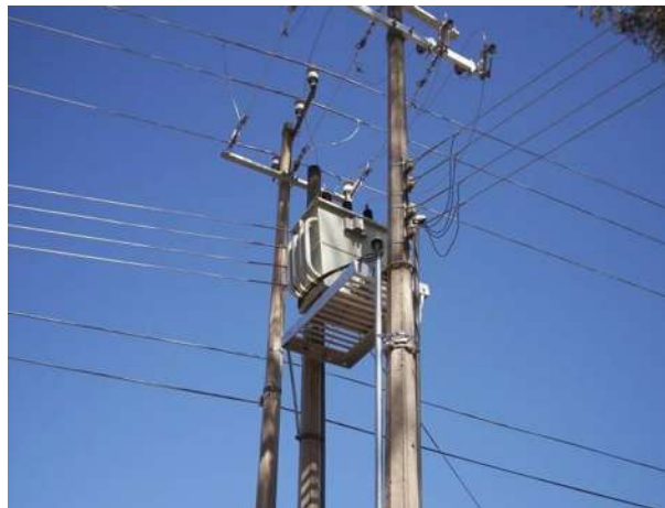
Figura 17 Vista de la subestacion ya remodelada nótese el cambio de herraje, y al transformador después de habersele dado mantenimiento.
