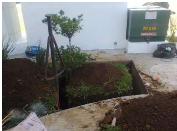
Figura 26 Excavación para el sistema de tierras que pidió la unidad de verificación por ser un lugar de concentración publica nótese el niño herramienta usada para introducir las varillas para el sistema de tierras ya que estas miden 3.05 mts de longitud
