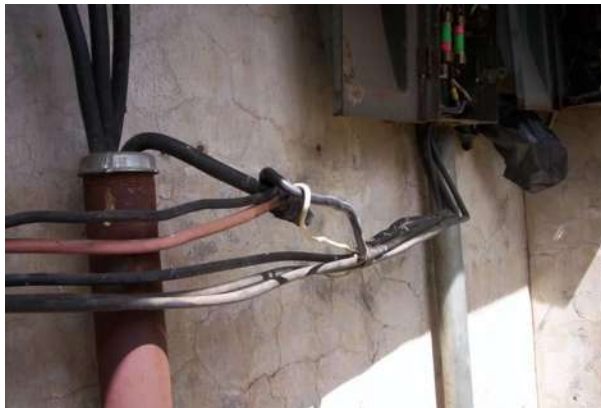
Figura 20 Vista de las conexiones existentes antes de la remodelación.
