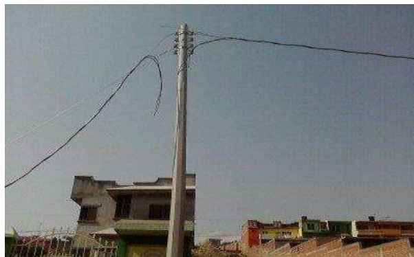
Figura 22 Tendido de conducto (2+1) 3/0-1/0 en la red de baja tensión en la escondida. Municipio de Zacapu Mich.
