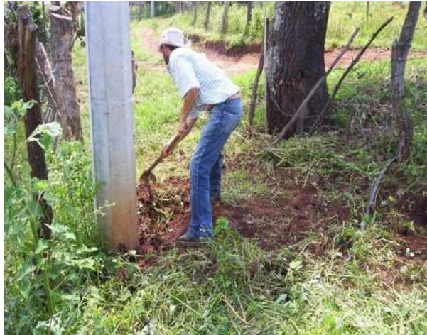
Figura 32 Vista del personal en la cual está tapando la delta para el sistema de tierras. Que nos pidió por parte de C.F.E. Para aterrizar el transformador
