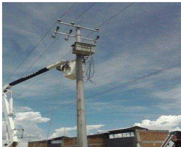
Figura 24 Colocación de transformador Trifasico de 30 kva en los corrales municipio de Zacapu Michoacán.
