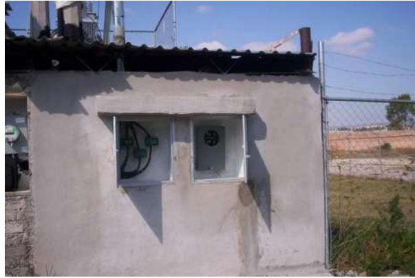
Figura 36 Vista de la base 13-20 así como de los transformadores de corriente propiedad de la C.F.E. Nótese en la parte superior la malla de la subestación a punto de cerrar .
