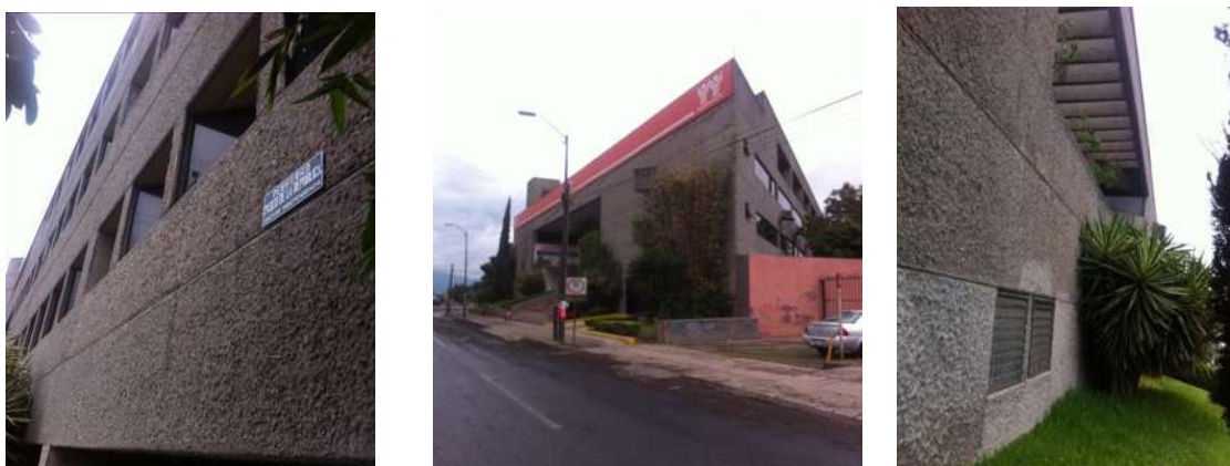
Figura 6 Impermeabilización de fachadas
