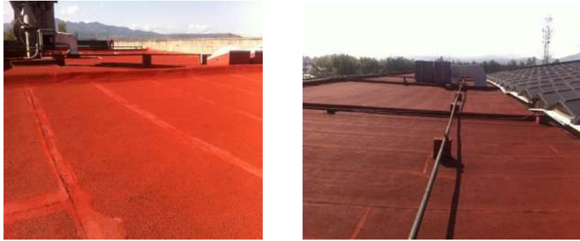
Figura 4 Impermeabilización de Azotea
