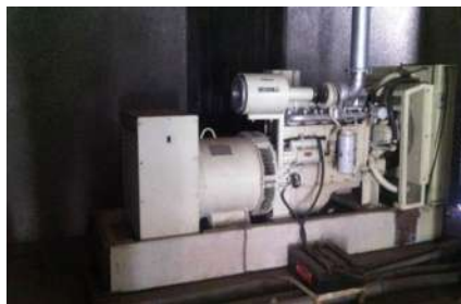
Figura 14 Planta de EMERGENCIA ó Grupo Electrónico
