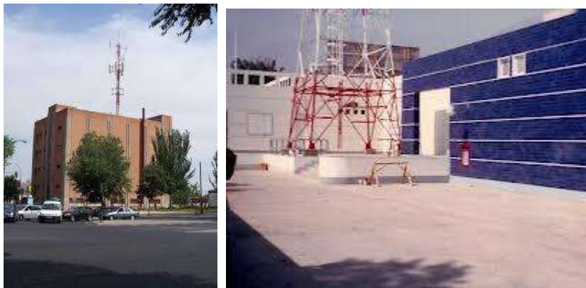
Figura 7 Edificio de una Central Telefónica
