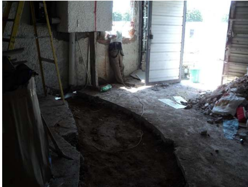
Figura 2.3.9 corte para realizar nuevo cuarto.
