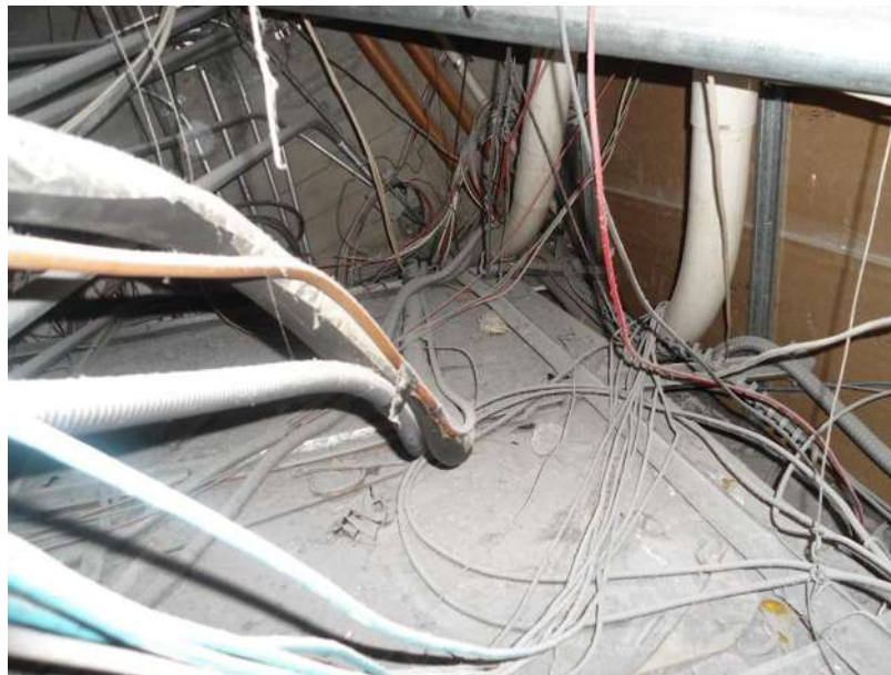
Figura 2.2.7desmantelamiento de instalación fuera de servicio.
