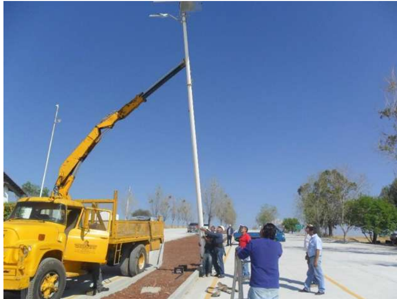
Figura 2.3.15 poste con lámpara solar.
