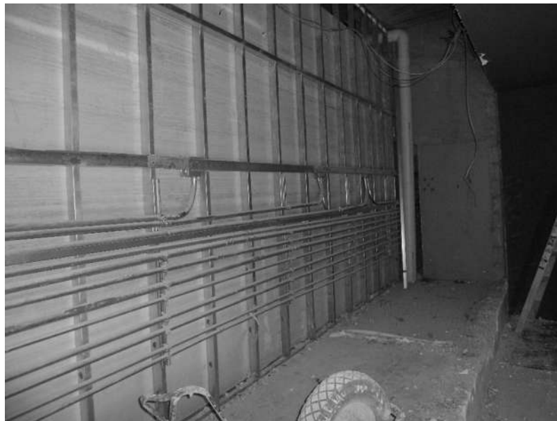
Figura 2.2.9 instalación de tubería.
