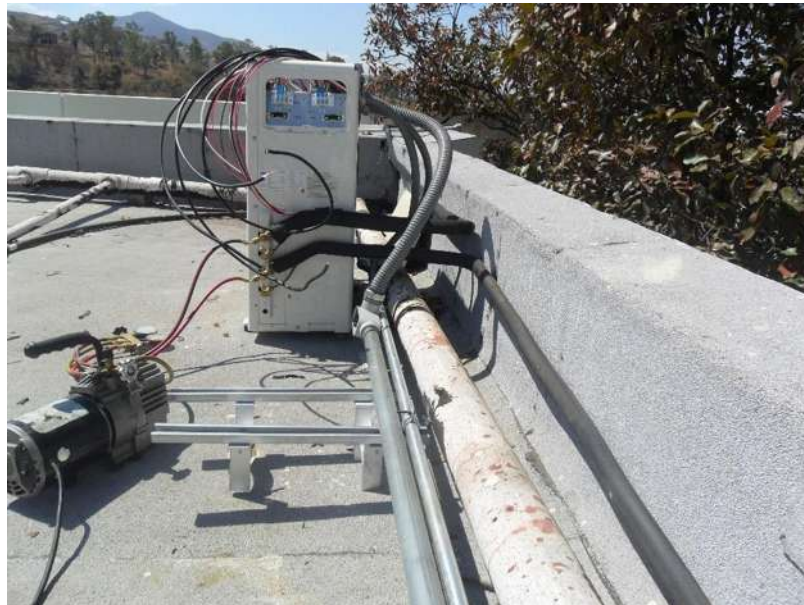
Figura 2.3.3 arranque de equipos de aire.
