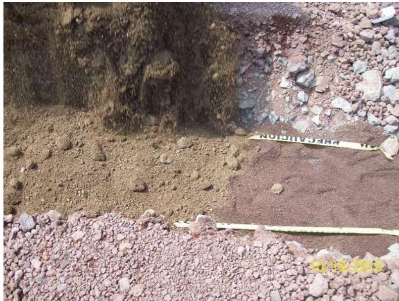
Figura 2.1.3 Colocación de cinta de precaución.
