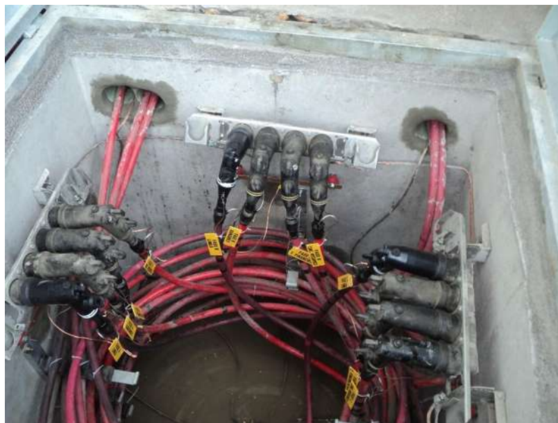
Figura2.3.10alimentaciones a trasformador.
