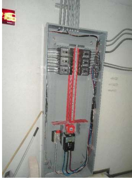
Figura 2.2.10 instalación de tablero I-LINE
