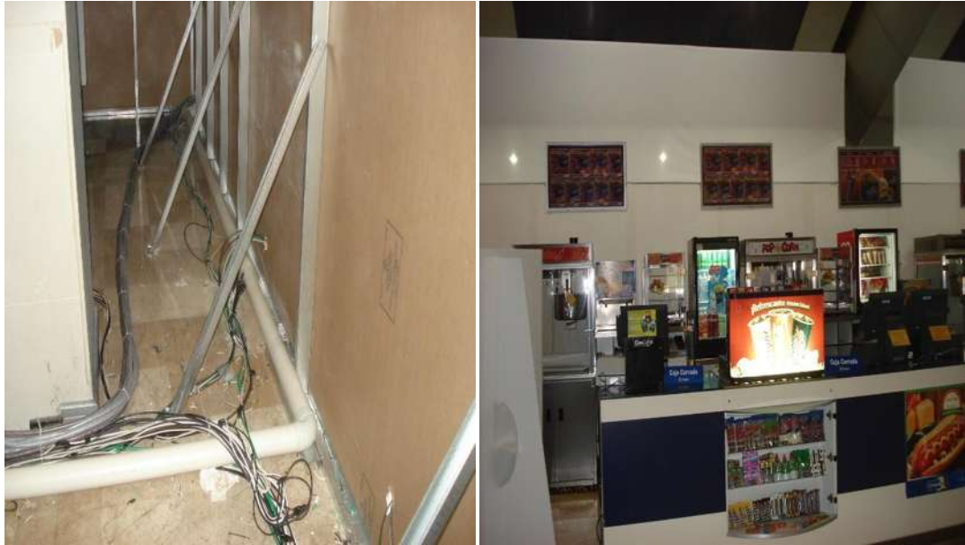
Figura 2.2.8 se puede observar la instalación provisional realizada para el funcionamiento de dulcería.
