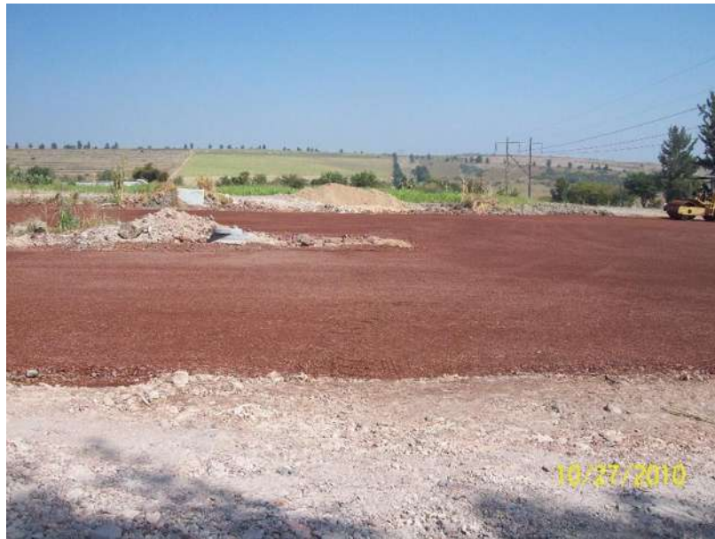
Figura 2.1.1 El nivel requerido para realizar trabajos.
