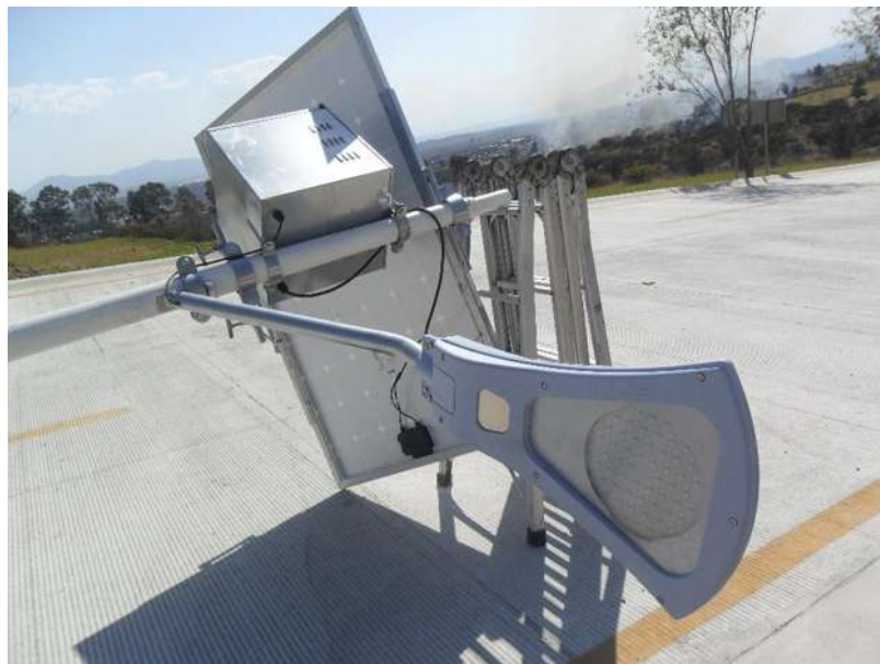
Figura 2.3.14Montaje de luminaria solar.
