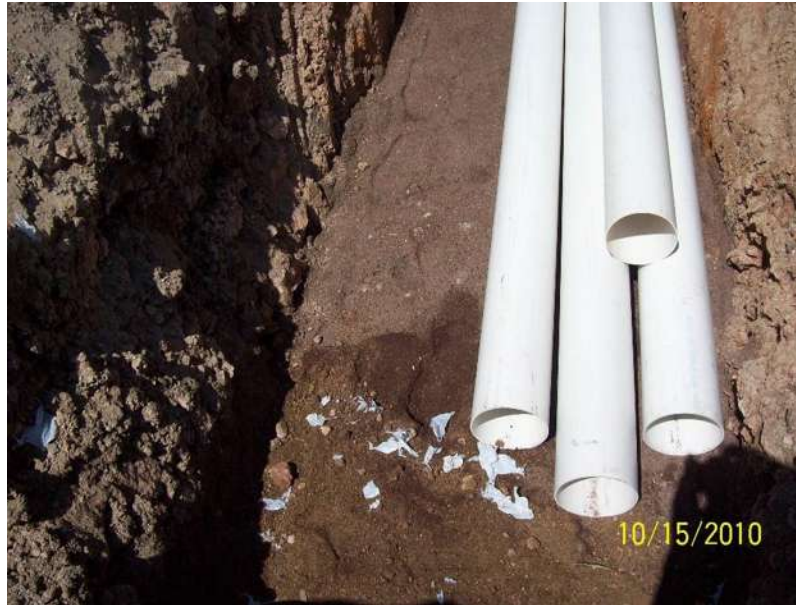
Figura 2.1.2 Colocación de ductería.
