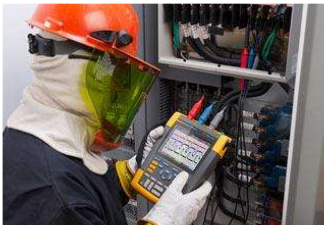
Figura 2.7 Osciloscopio de mano
