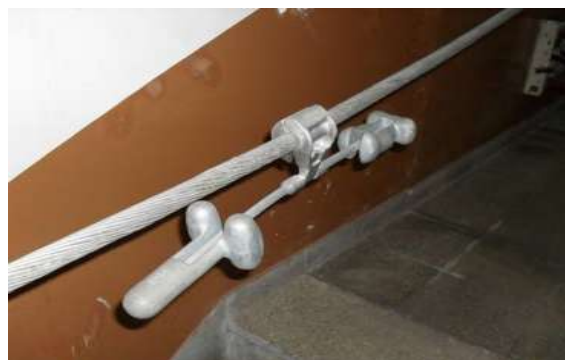
Figura 55 Amortiguado de vibración
