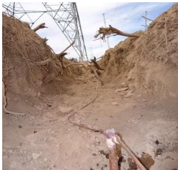
Figura 36 Conexión de cable de cobre
