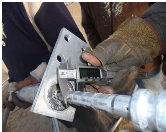
Figura 45 Medición de empalme interior
