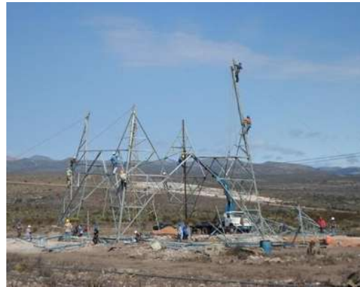
Figura 27 Montaje Bottom Panel
