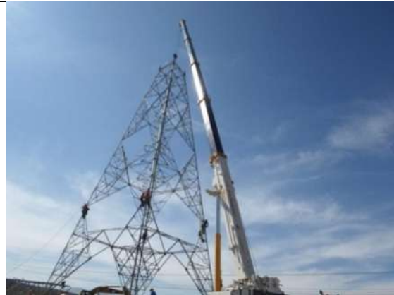
Figura 31 Montaje con grúa hidráulica
