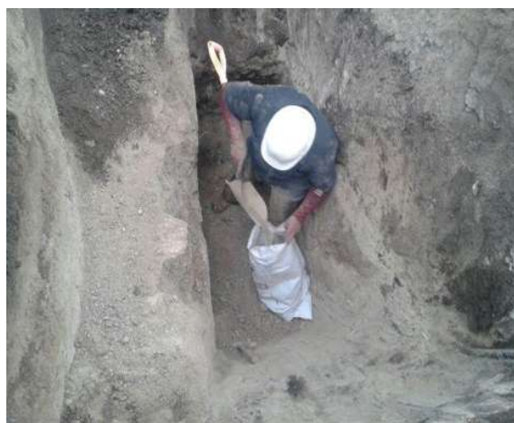
Figura 14 Sondeo a cielo abierto
