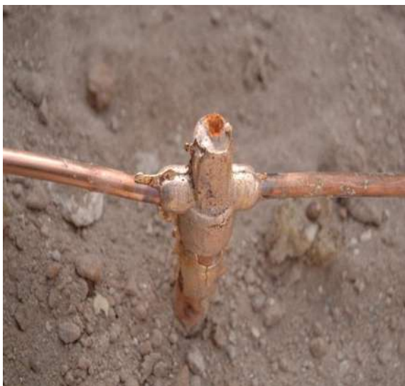
Figura 35 Hincado de varillas de cobre
