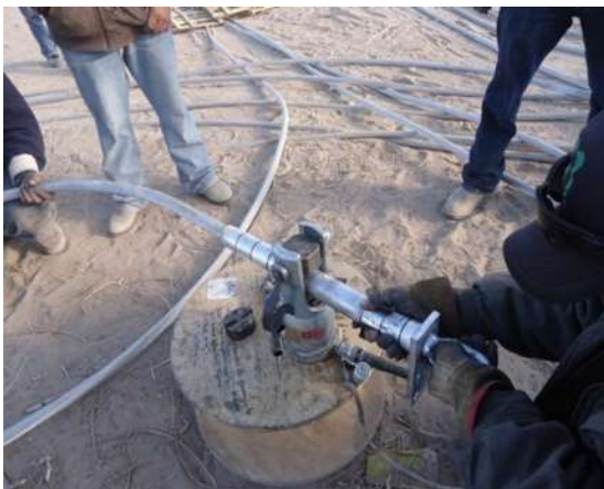
Figura 42 Cabezal para hacer empalme en cable ACSR
