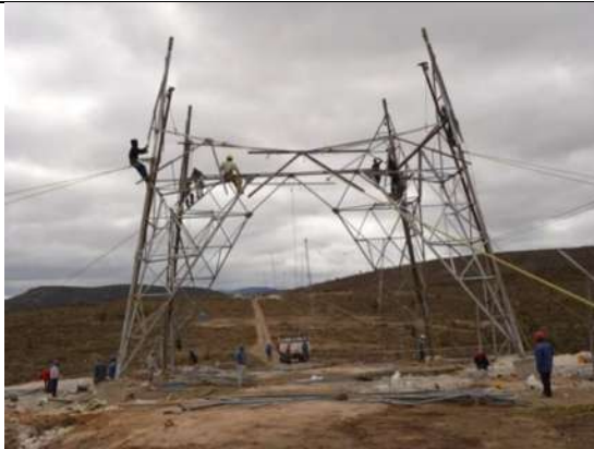
Figura 30 Montaje con pluma flotante
