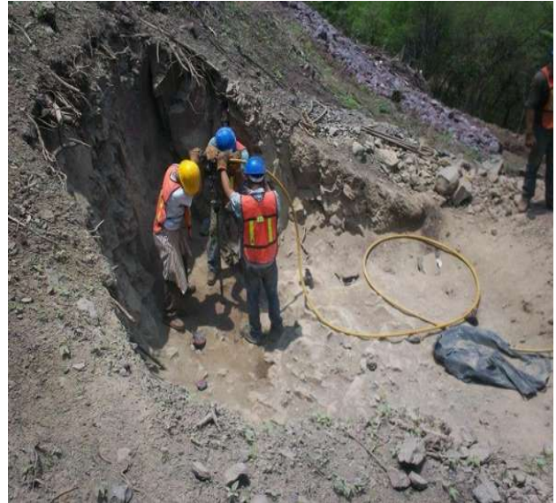
Figura 22 Perforación para Cimentaciones ancladas
