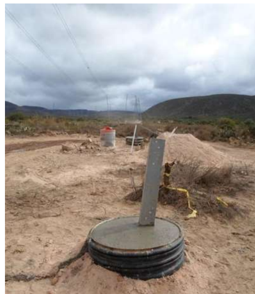
Figura 24 Pila de cimentación
