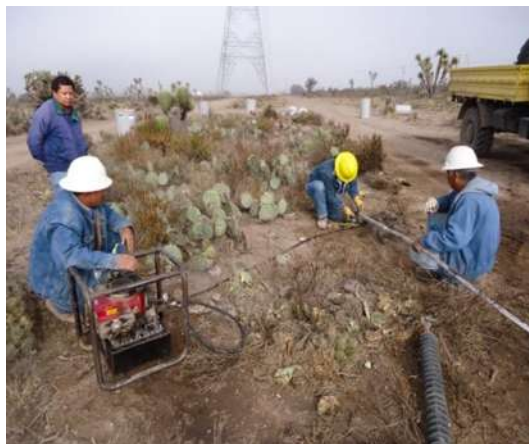
Figura 43 Para empalme en cable ACSR
