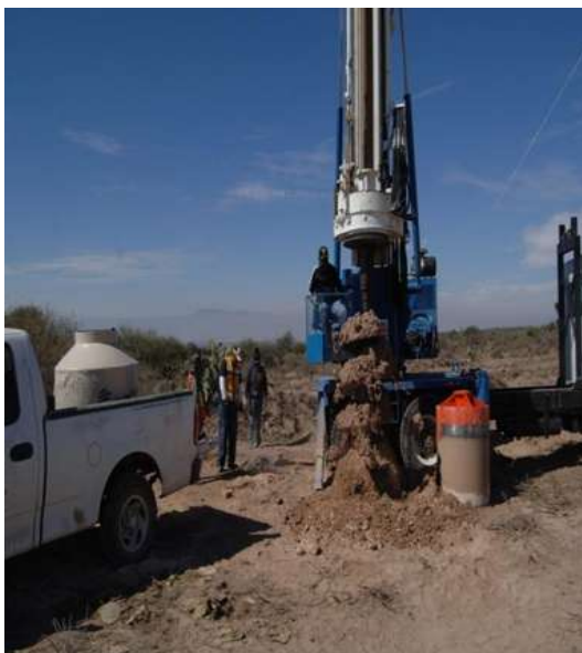
Figura 23 Excavación para Pilas
