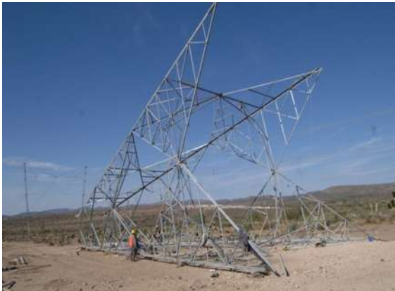
Figura 28 Pre armado cuerpo piramidal
