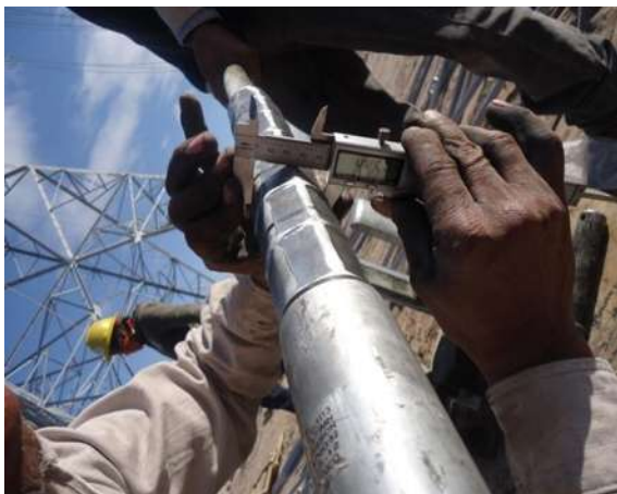
Figura 44 Medición de empalme exterior
