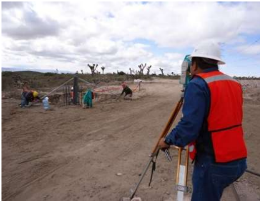
Figura 26 Nivelación de Bottom Panel
