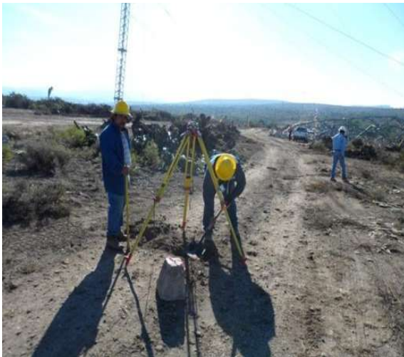
Figura 19 Localización de Estructuras
