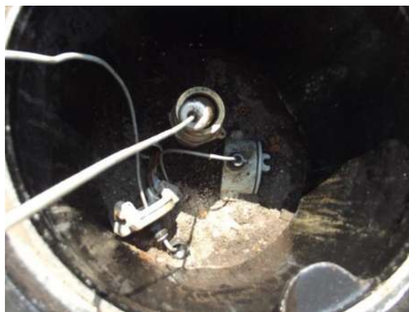
Figura 3.9 Sensor electrónico de espacio anular
