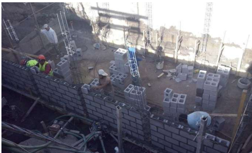
Figura 3.4 Trabajo de adecuación para alojamiento de tanque de almacenamiento
