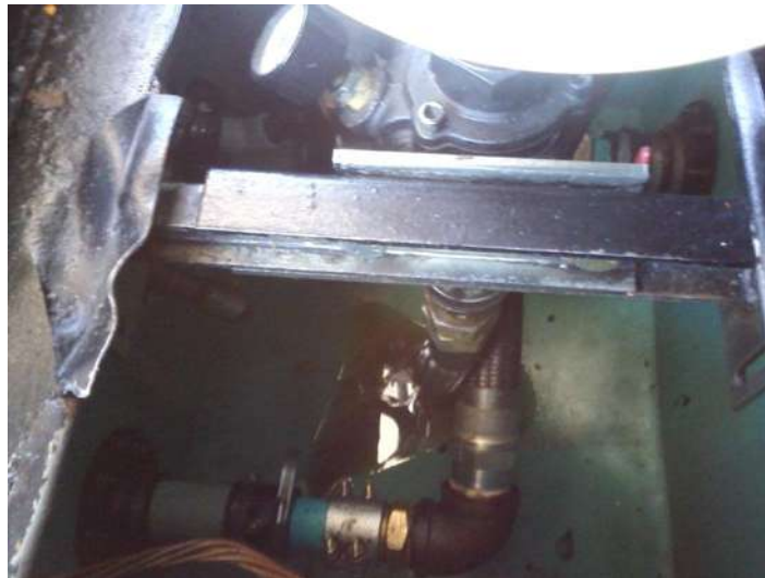
Figura 2.9 Tuberías de alimentación y derivación para satélite.
