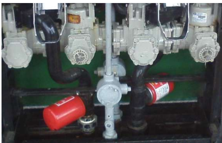
Figura 2.5 Sistema hidráulico de dispensario de 2 productos.
