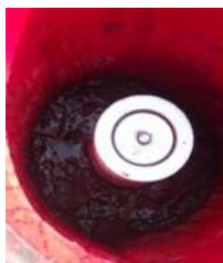
Figura 3.11 Toma para recuperación de vapores
