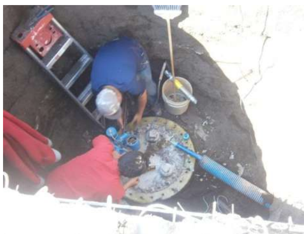
Figura 3.5 Lomo superior del tanque de almacenamiento.
