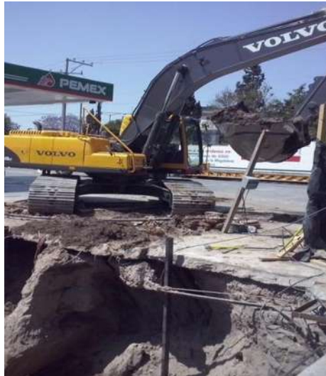
Figura 3.3 Adecuación del terreno.
