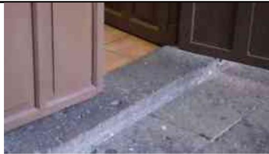
En el segundo patio y en algunos espacios interiores se observa otro tipo pavimento: piso de pasta de cemento en rojo. Este piso es muy liso por lo que es adecuado para el deslizamiento de silla de ruedas pero no tanto para desplazamiento con muletas, por ejemplo.
