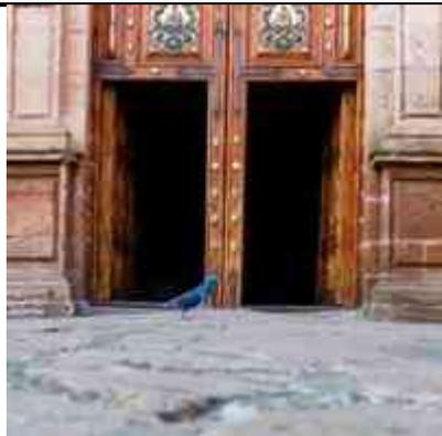
Lo que se observa en la imagen es la parte inferior de la puerta de ingreso. Representa una barrera infranqueable de manera independiente, para una persona en silla de ruedas, y una barrera difícil para todos los demás.
