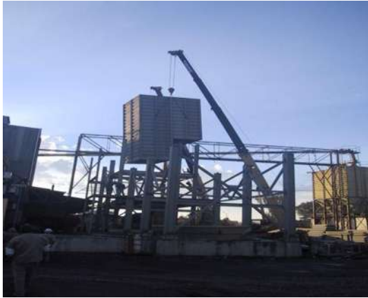
Figura 24.- Montaje de depósitos en estructura
