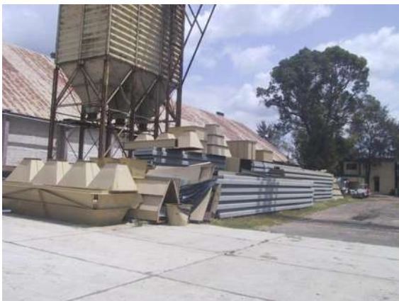
Figura 22.-Recepción de materiales en Obra
