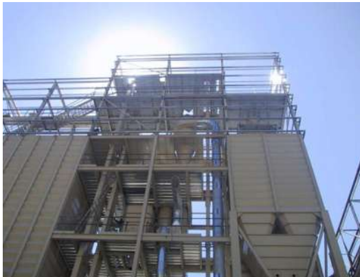
Figura 26.- Vista general de la Planta
