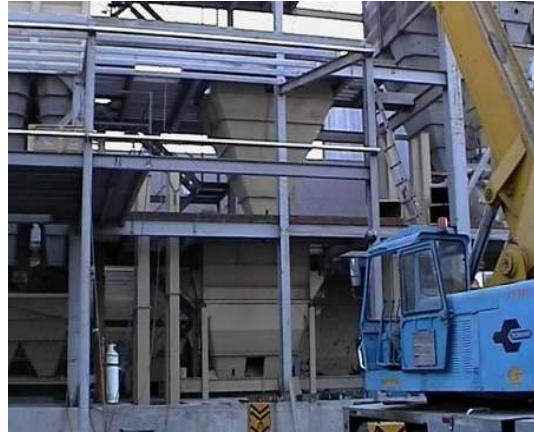
Figura 25.- Montaje de máquinas en diferentes niveles
