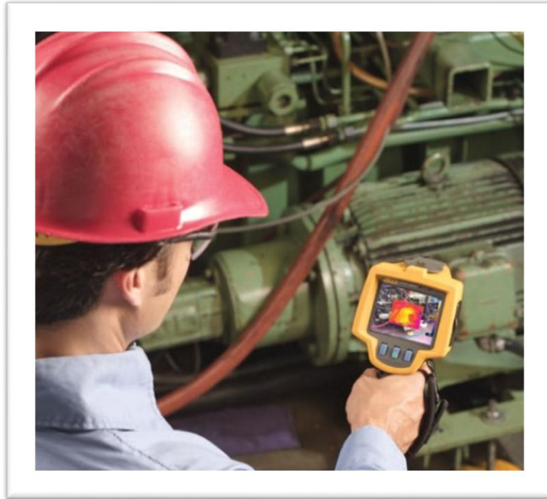
FIGURA 11.- MANTENIMIENTO PREVENTIVO DE MOTORES ELECTRICOS
