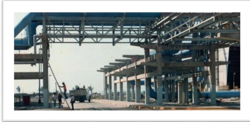
FIGURA 5.- DUCTOS DE ALIMENTACIÓN DE AGUA
