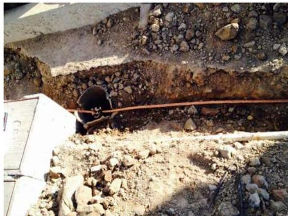
Figura 5.13.- Instalación de Sistemas de tierras
