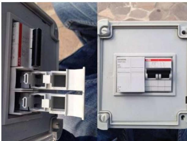
Figura 5.9.- Caja Table Plast con porta Fusibles e Interruptores para CD
