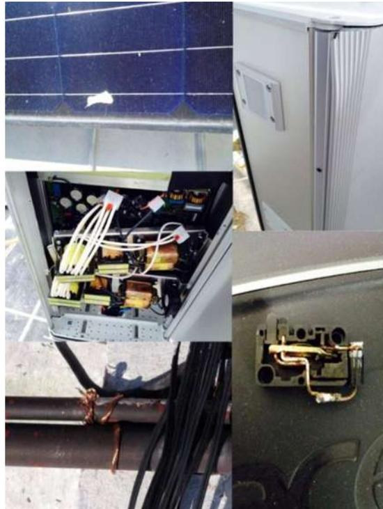
Figura 5.12.- Módulos con Chicle, Daños En Inversores, Switch dañado, Sistemas Mal Aterrizados
