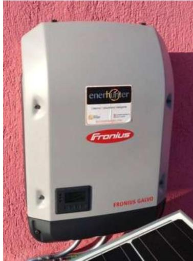
Figura 5.5.- Montaje Final del inversor
