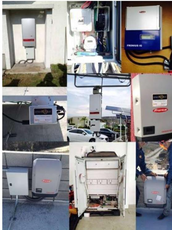
Figura 5.6.- Montaje de diferentes inversores
