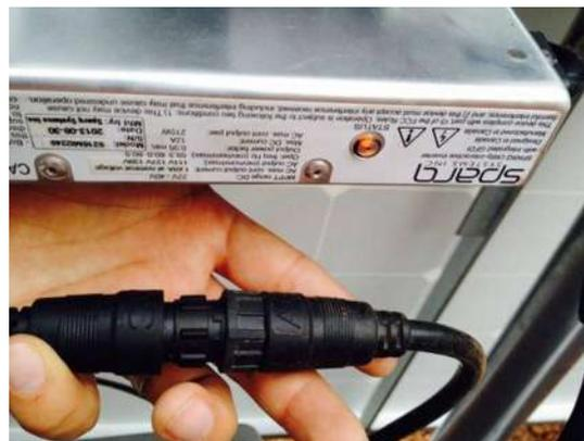
Figura 5.2.- Cable de AC que se conecta entre inversores
