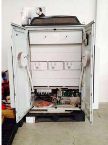
Figura 5.7.- Inversor Central de Fronius
