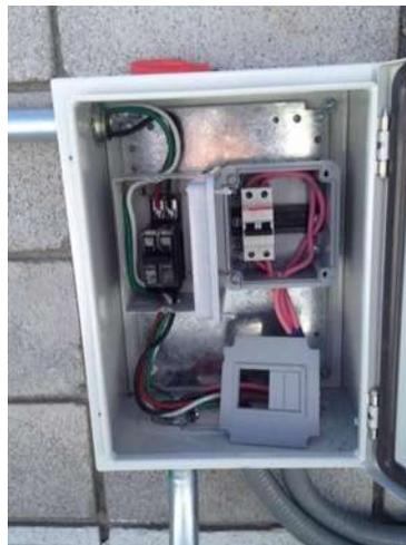
Figura 5.8.- Instalación de protecciones para el sistema fotovoltaico
