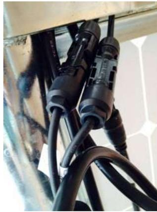
Figura 5.1.- Conector MC4 del Micro-Inversor conectado al panel
