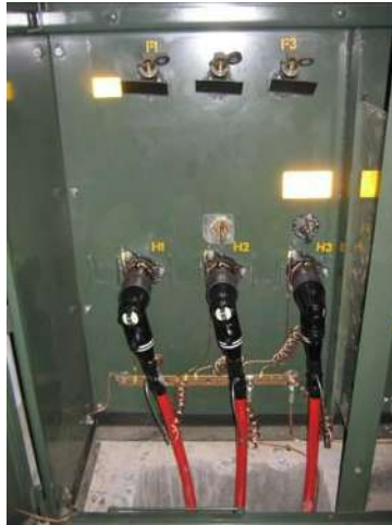
Figura 15.- Conexión de los codo O.C.C.
