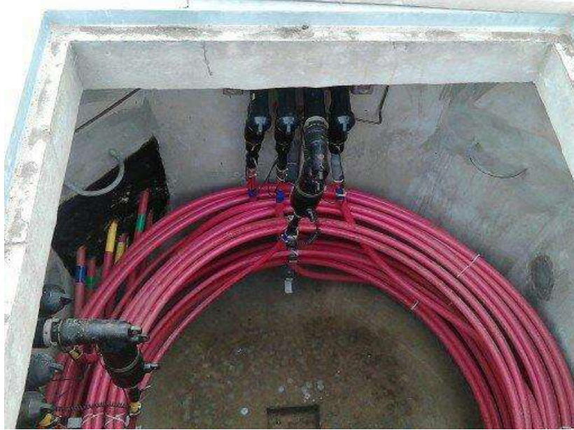
Figura 27.- Caja derivadora j4 en 600 Amp, cuerpos T para 600 Amp, y reducción a 200 Amp.
