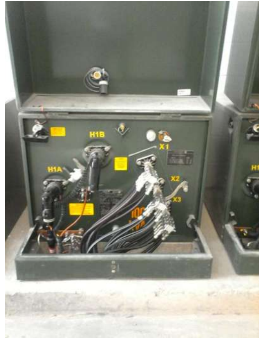
Figura 43.- Transformadores monofásicos operación anillo pedestal de 100Kva, 13.2Kv-220/127V, para alimentación de cargas de departamentos.
