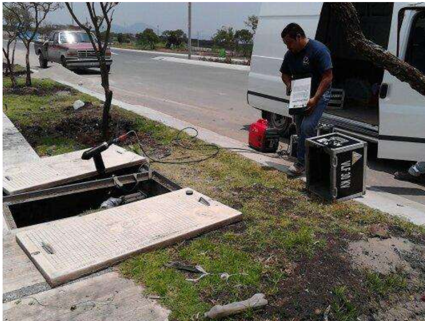
Figura 26.- Pruebas de VLF a los cables de potencia para energizar la línea.
