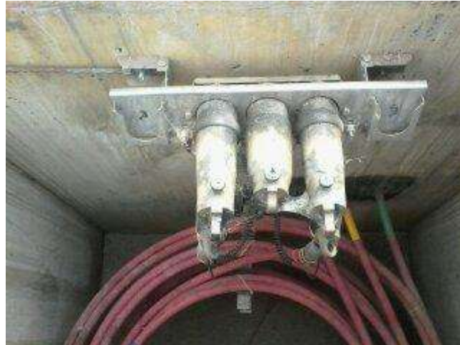
Figura 25.- Aquí se muestran los herrajes en una caja derivadora de 600 Amp. para 500 mcm.
