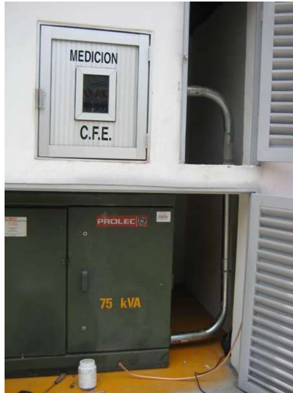
Figura 9.- Subestación terminada
