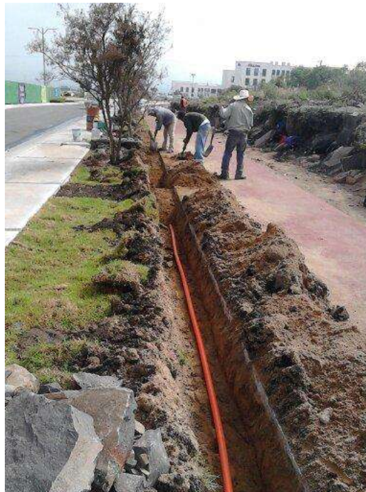
Figura 30.- Instalación de canalización para sistema de alumbrado público.
