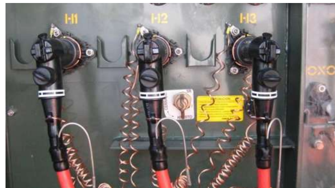
Figura 4.- Codos de O.C.C. en el lado de M.T.
