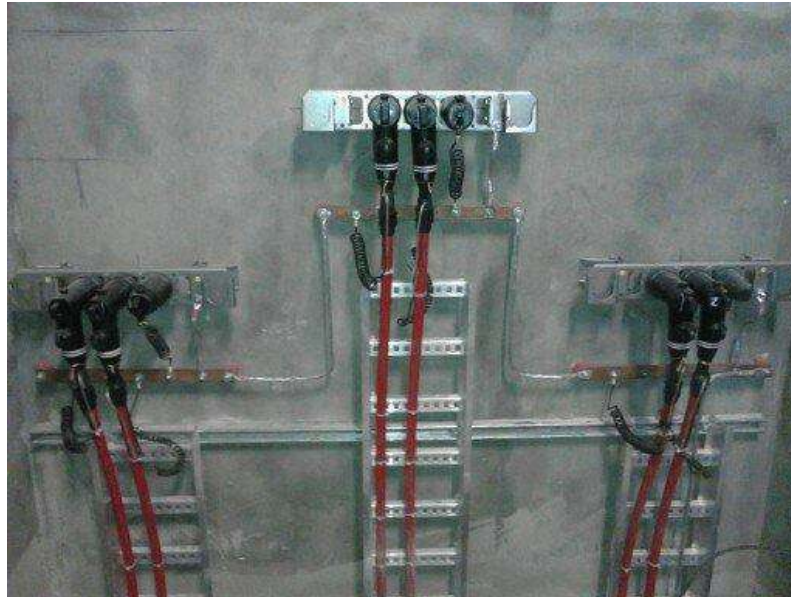
Figura 36.- Cajas derivadoras j3 en 200Amp.
