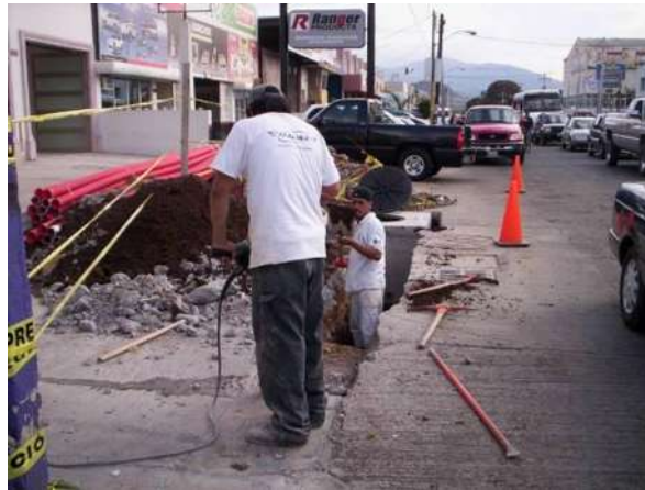
Figura 22.- Instalación de registros de media tensión y ductos.
