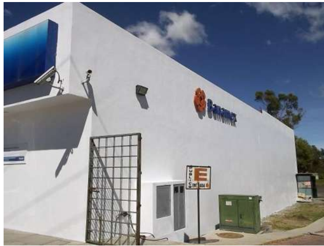
Figura 1.- Subestación tipo pedestal
