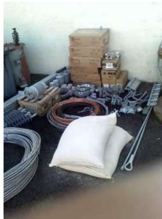
Figura 17.- Materiales utilizados para ejecutar el cambio de transformador.
