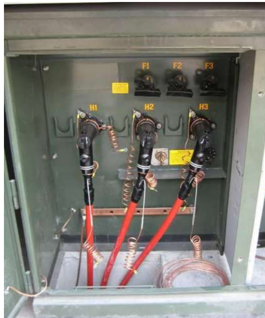
Figura 8.- Terminales tipo codo O.C.C.
