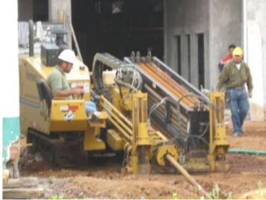
Figura 13.- Perforado unidireccional
