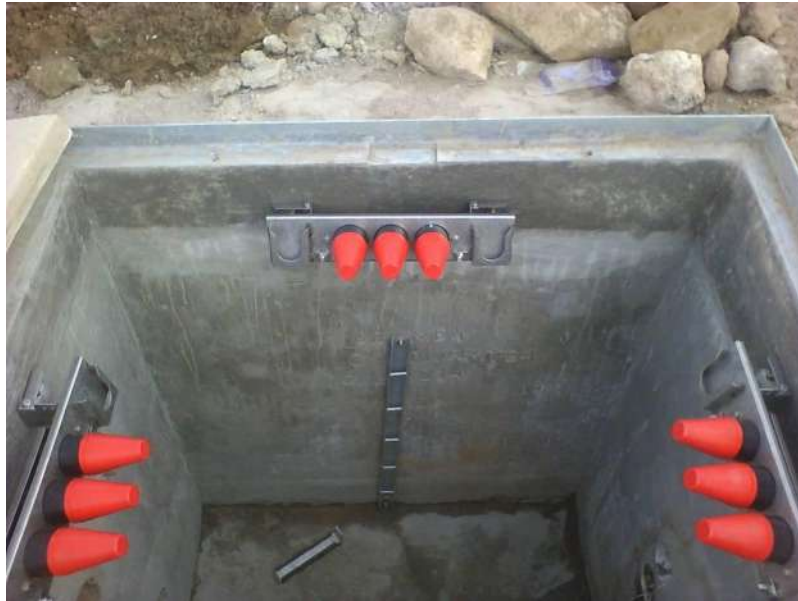
Figura 31.- Instalación de cajas derivadoras j3 en 200 Amp en registro tipo 4.
