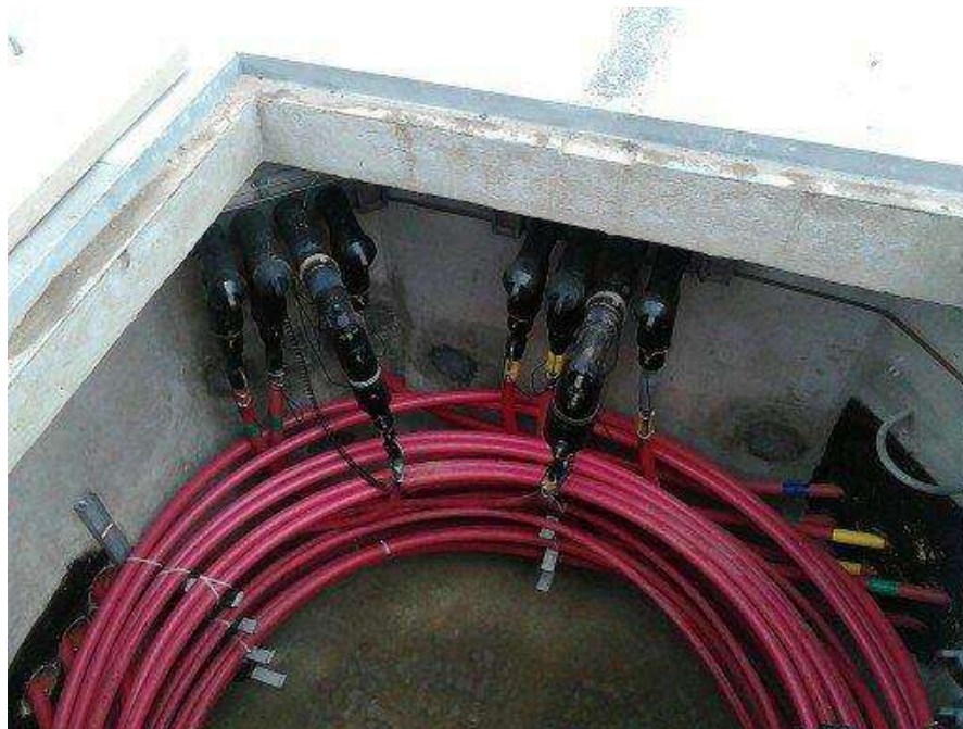
Figura 28.- Caja derivadora j4 en 600 Amp, cuerpos T para 600 Amp, y reducción a 200 Amp en un registro tipo X.
