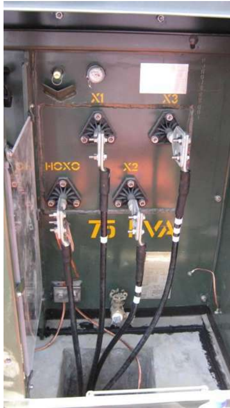
Figura 5.- Conexión en el lado de B.T.
