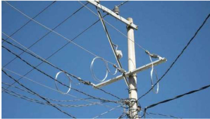
Figura 24.- Aquí se muestran los herrajes y el poste en el cual se hará el entronque para alimentar nuestra subestación.
