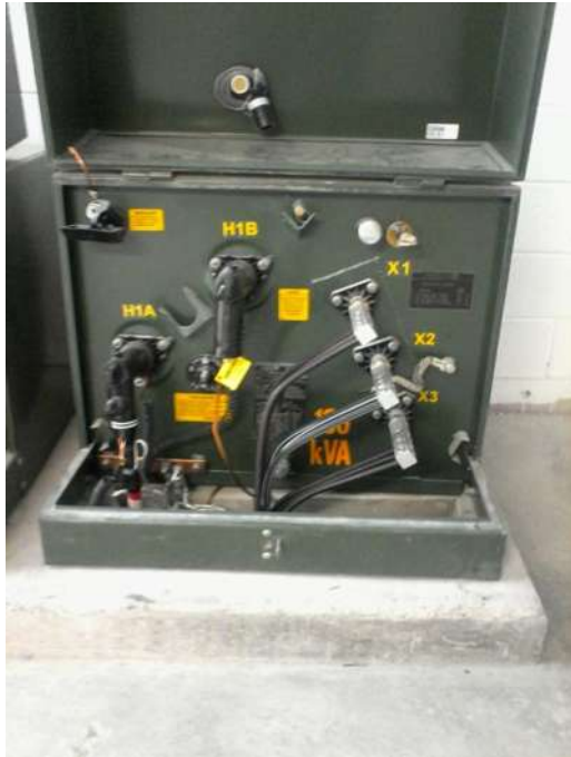
Figura 43.- Transformadores monofásicos operación anillo pedestal de 100Kva, 13.2Kv-220/127V, para alimentación de cargas de departamentos.
