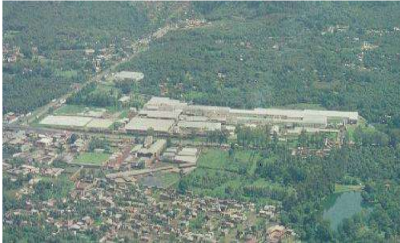
Figura 2.- Vista panorámica de la Planta
