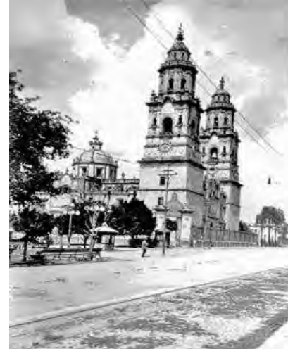
Fig. 30. Rieles y cables de luz, sobre la calle Nacional, utilizados por el tranvía eléctrico. Fuente: Colección Romo.
