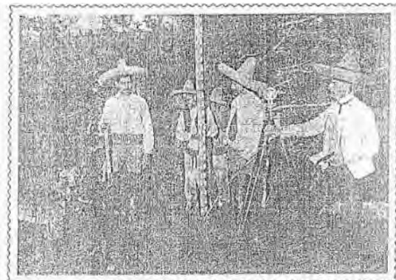
Primeros trazos de las obras para la Planta de luz y fuerza "LA TRINIDAD."
