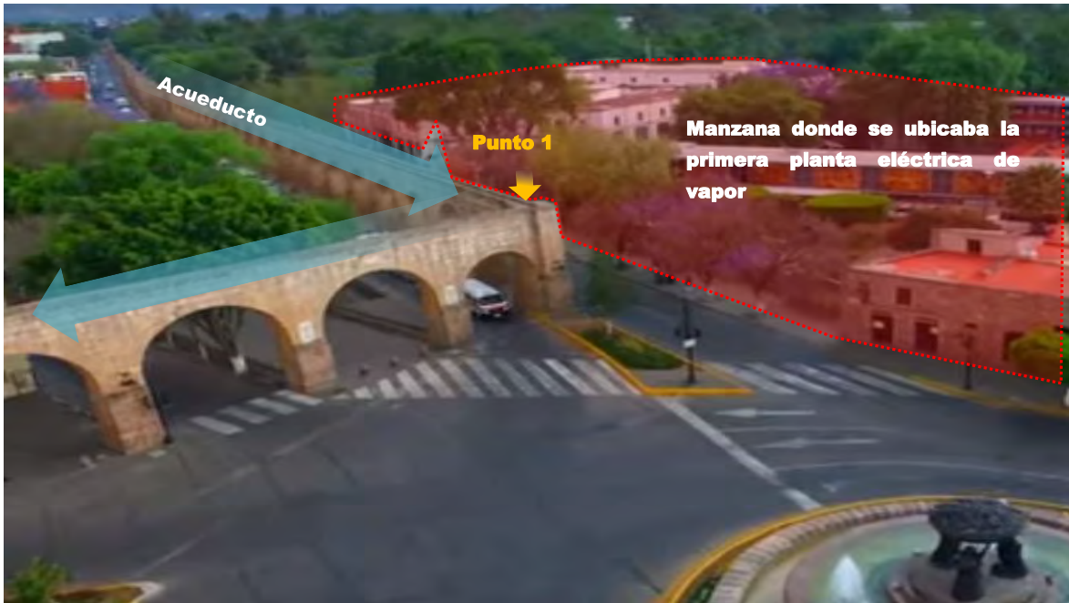
Figura 23. Fotografía aérea del acueducto de Morelia. Fuente: https://www.youtube.com/watch?v=L0bJi9LRjYQ
