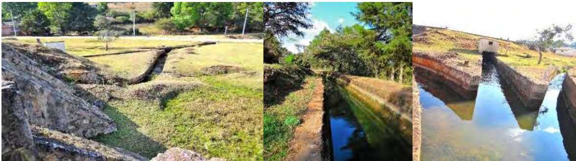
Figura 33. Red hidráulica utilizada para el abastecimiento del agua para la planta hidroeléctrica de La Trinidad.
