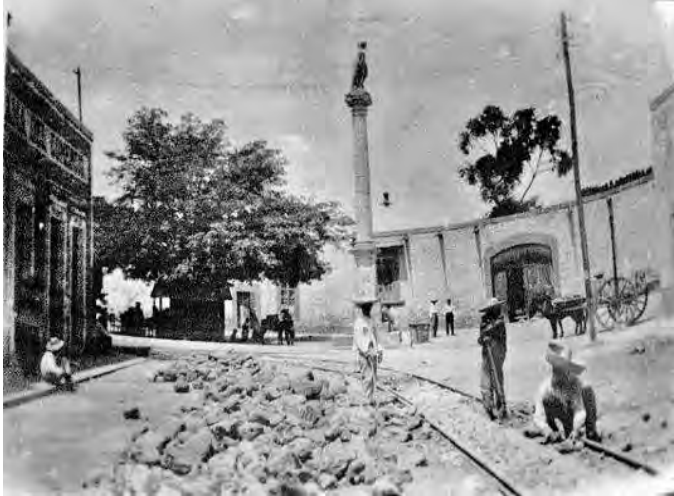
Figura. 29. Instalación de rieles en una vialidad de la ciudad de Morelia. Fuente: Colección Romo.
