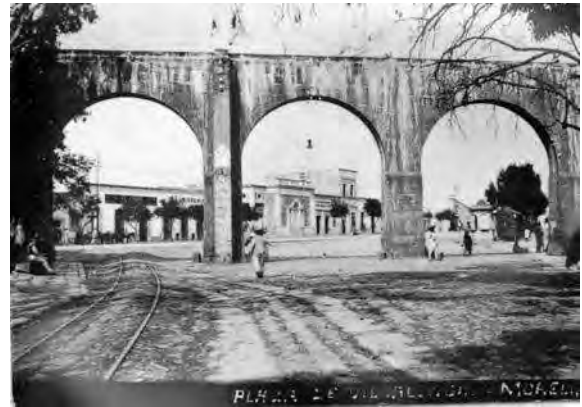
Figura 43. Instalación de la red eléctrica y de lámparas sobre el acueducto de Morelia. Fuente: Colección particular del señor Romo.
