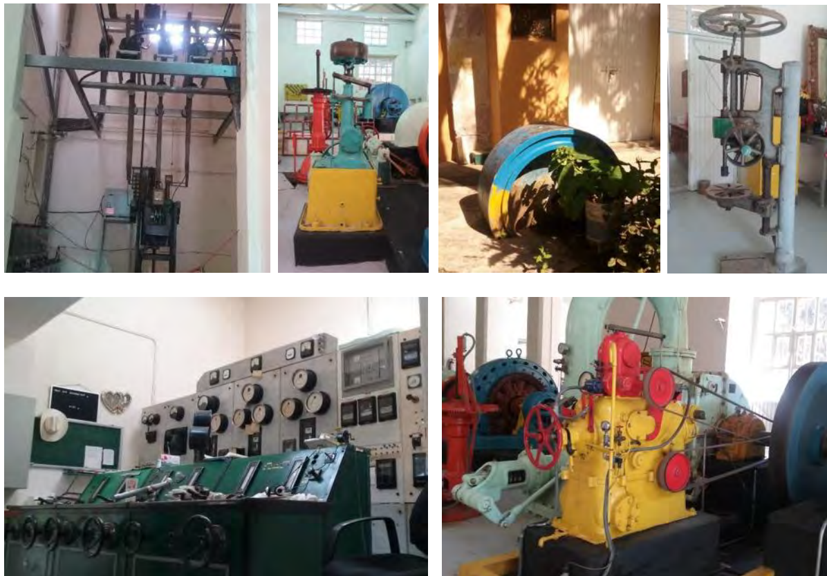
Figura 50. Piezas que conformaron la planta hidroeléctrica original.
