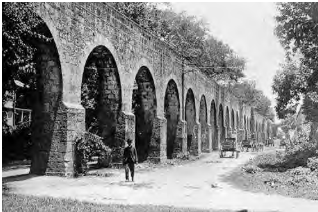
Figura 42. Instalación de la red eléctrica sobre el acueducto. Fuente: Colección particular del señor Romo.
