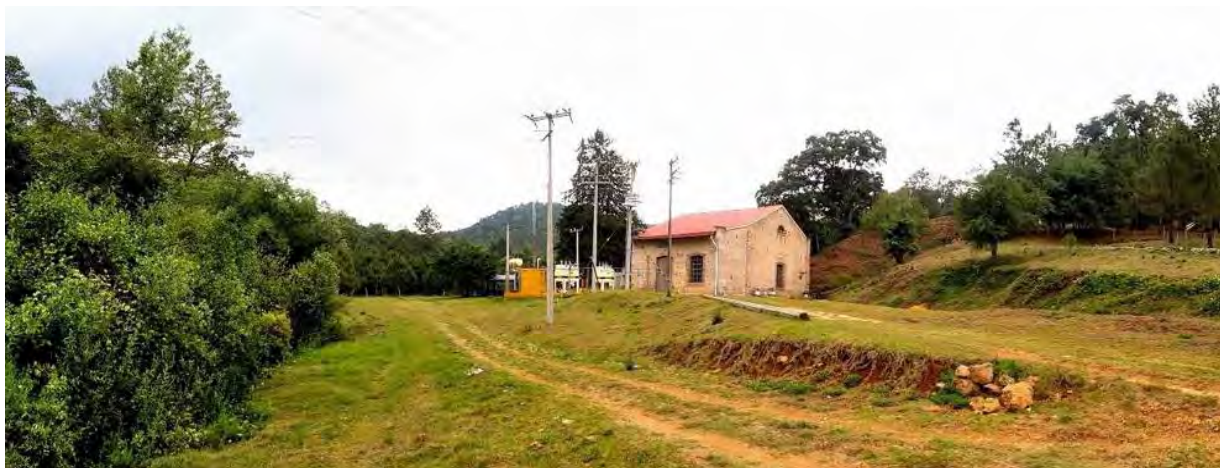
Figura 53. Paisaje industrial instalado dentro del perfil del paisaje natural.
