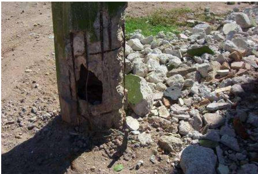
**Figura 3. 6.- Poste con varillas descubiertas**
