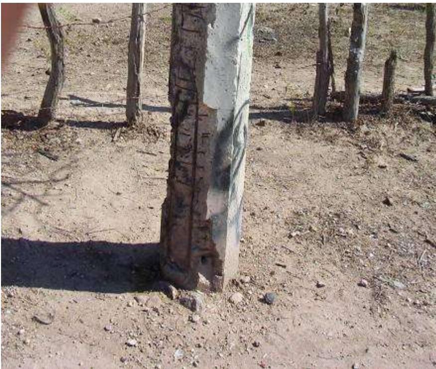
**Figura 3. 10.- Poste dañado parcialmente.**
