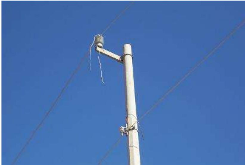
**Figura 3. 46.- Alambre de aluminio AS4 para amarrar a conductor.**
