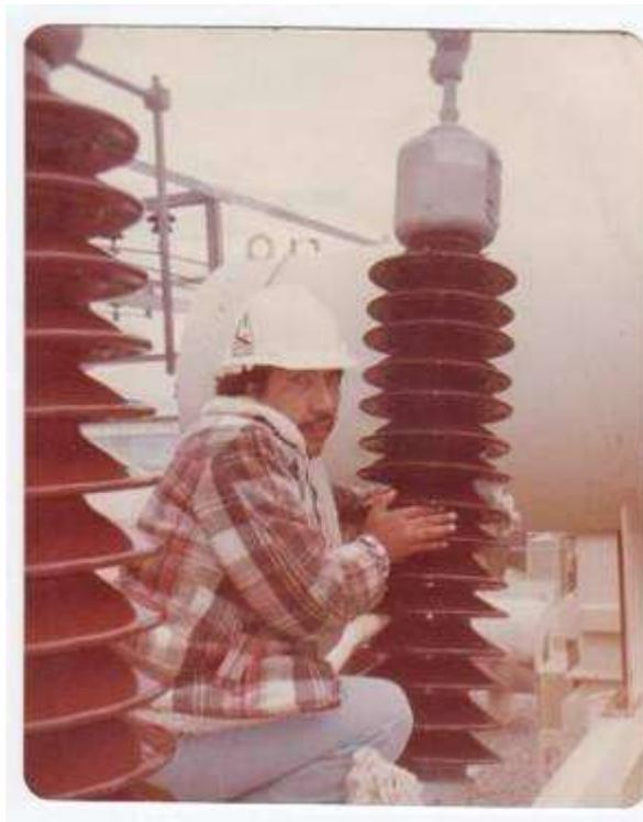
**Figura 3. 35.- Limpieza de aisladores del transformador principal.**
