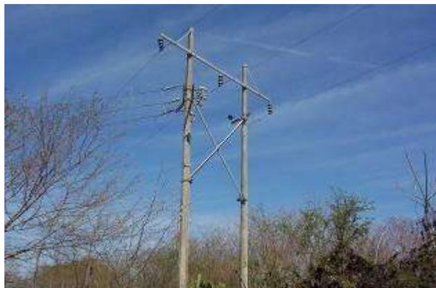
**Figura 3. 13.- Estructura con crucetas flexionadas.**
