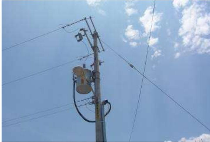
**Figura 3. 21.- Red de construcción híbrida (aéreo subterránea).**
