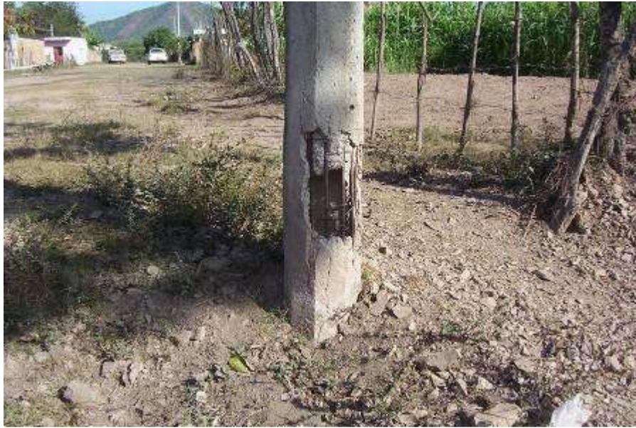
**Figura 3. 5.- Poste con varillas descubiertas.**
