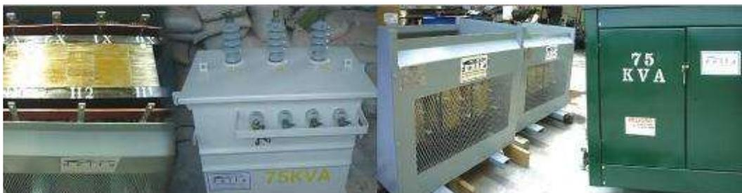
**Figura 3. 54.- Transformadores de distribución de diferentes capacidades.**
