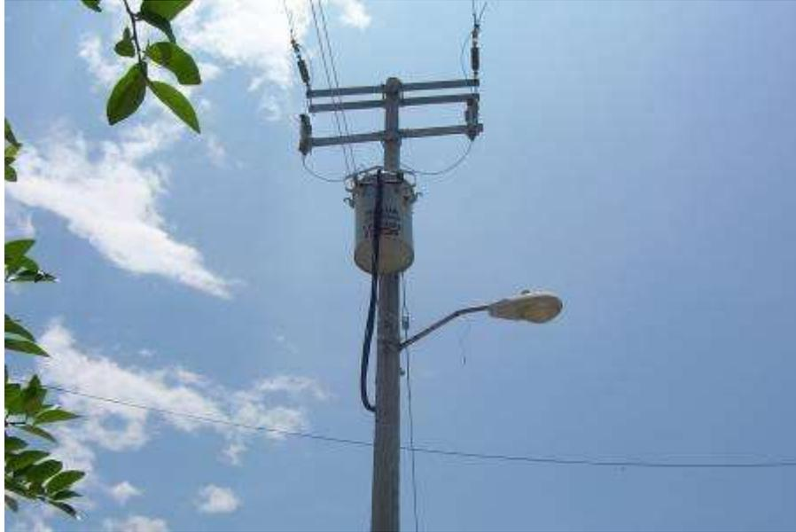
**Figura 3. 26.- Estructura con transformador y acometida subterránea.**
