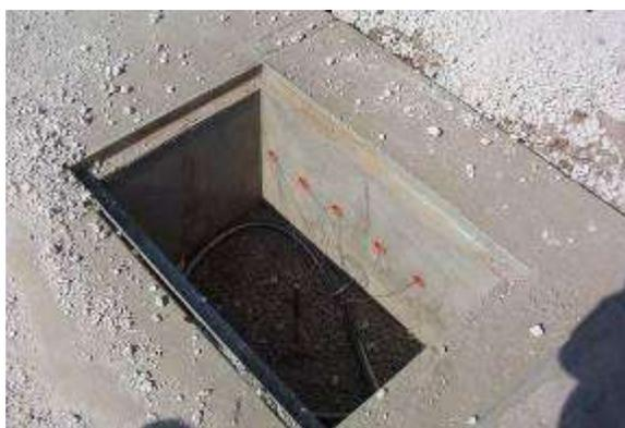
**Figura 3. 24.- Registro para alojar cables de acometidas en baja tensión.**
