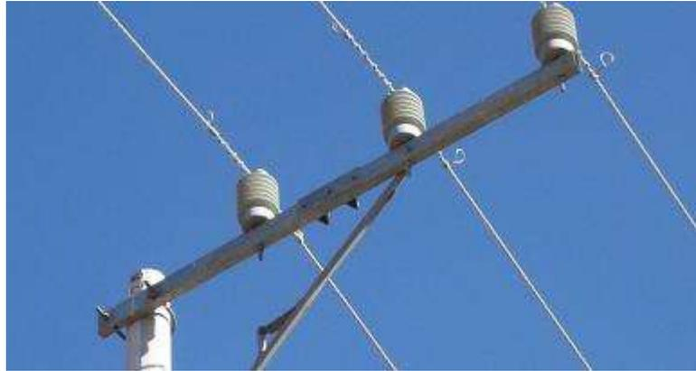
**Figura 3. 38.- Estructura tipo VS30 volada sencilla tres fases.**
