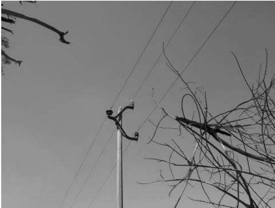
**Figura 3. 1.- Estructuras de paso con cruceta tipo Anáhuac**
