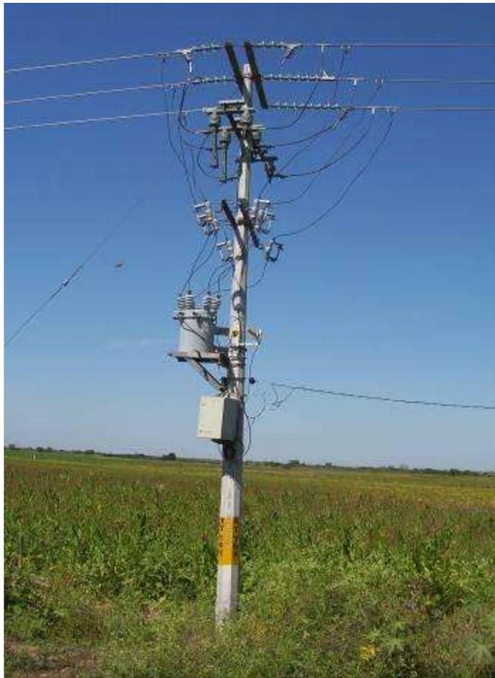
**Figura 3. 36.- Estructura con restaurador.**
