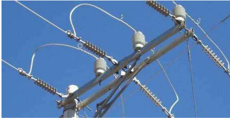
**Figura 3. 42.- Estructura tipo VD30 volada doble y anclaje tres fases.**
