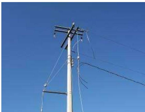
**Figura 3. 25.- Estructura con doble remate en proceso de construcción.**
