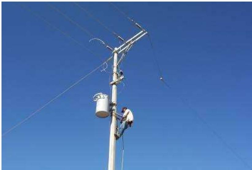
**Figura 3. 45.- Montando equipo de transformación.**
