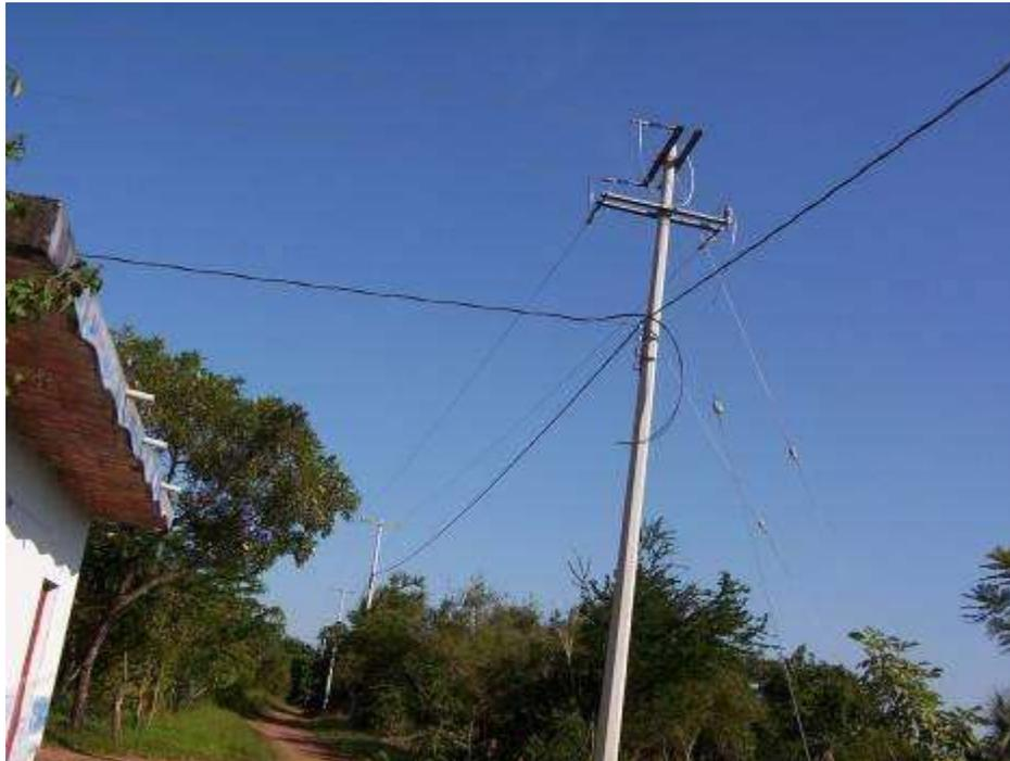
**Figura 3. 27.- Estructura con media tensión y baja tensión con cable semiaislado en proceso de construcción.**
