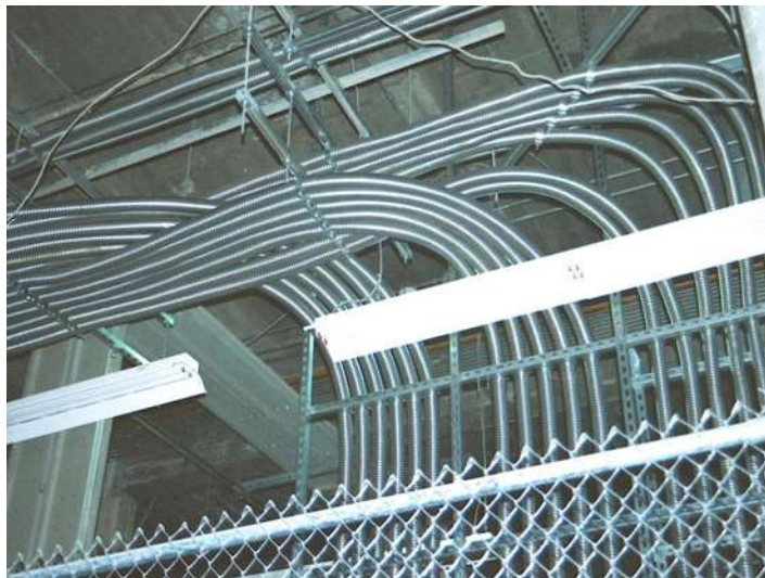
Figura 17.- Alimentadores Principales con Cable de Aluminio Tipo MC
