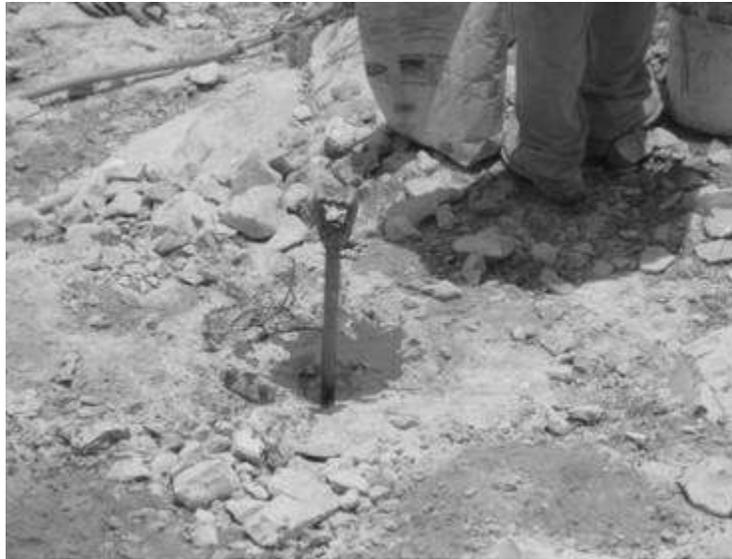
**Figura 41.- Forma de instalar anclaje tipo taquete**
