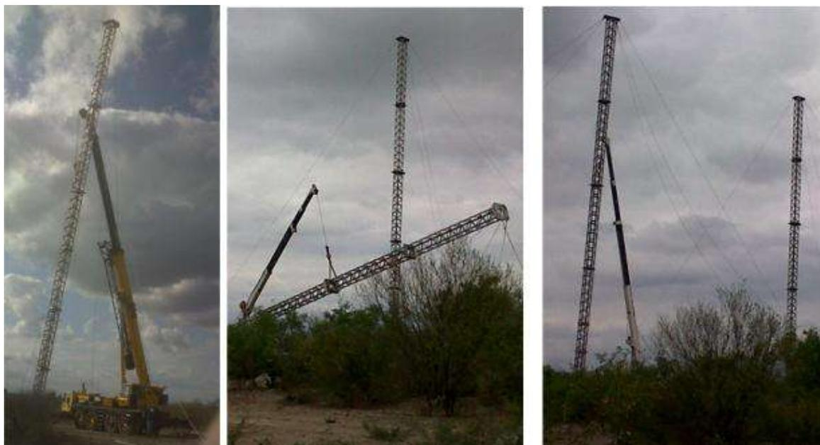
Figura 45.- Maneras de izar una columna con grúa
