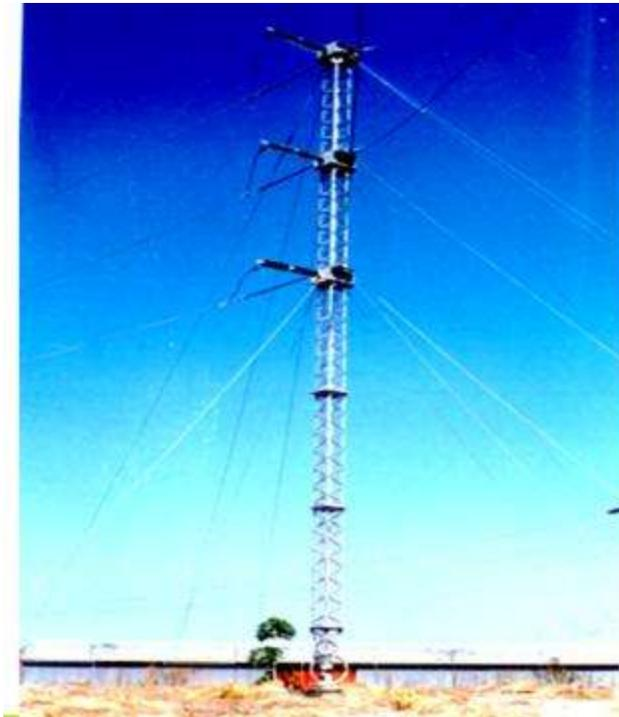
Figura 36.- Estructura tipo bandera remate 230 kv
