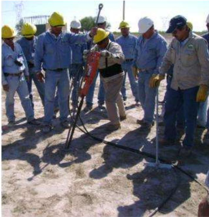
**Figura 39.- Practica de instalación de ancla tipo mantarraya**
