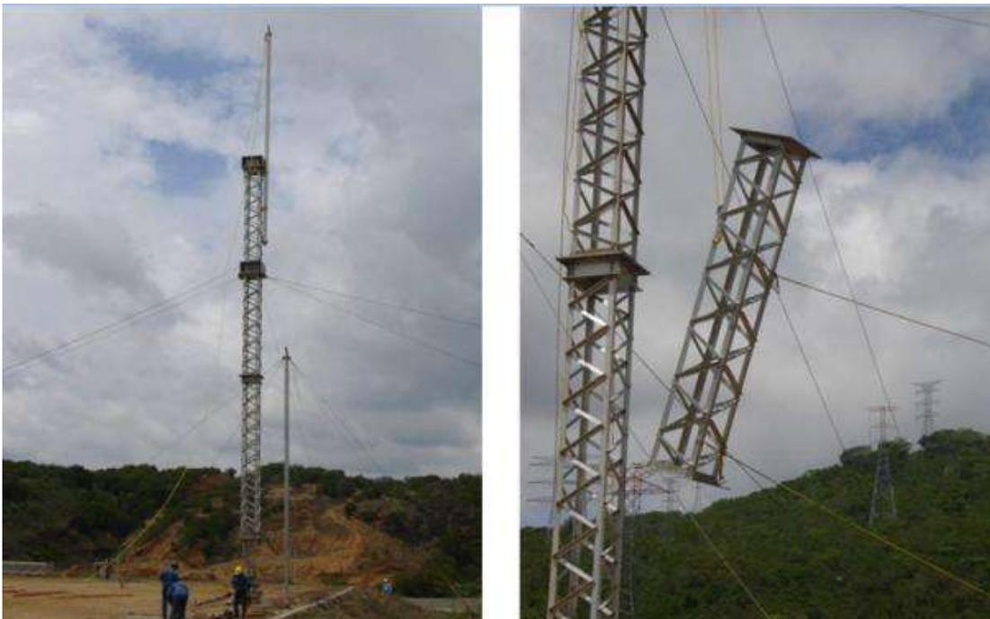
**Figura 49.- Armado de estructura pieza por pieza cuando no es posible con grúa ni helicóptero**
