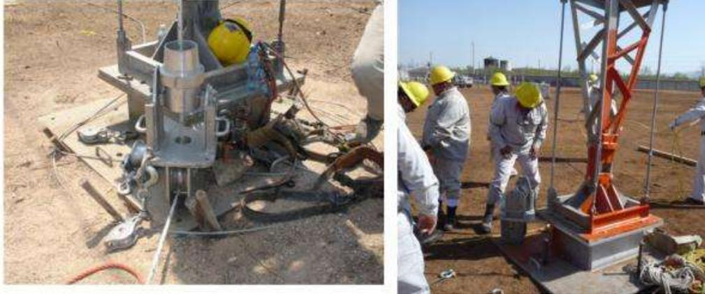
**Figura 53.- Instalación de la base de la pluma deslizante**
