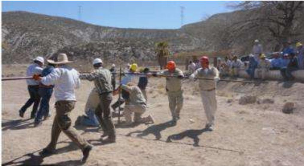
Figura 43.- Con una cruceta se gira el ancla y sola se va enterrando
