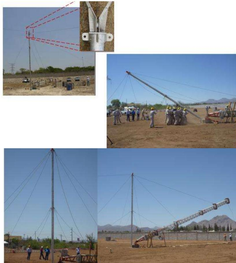
Figura 47.- Instalación de pluma de piso para izaje de columna
