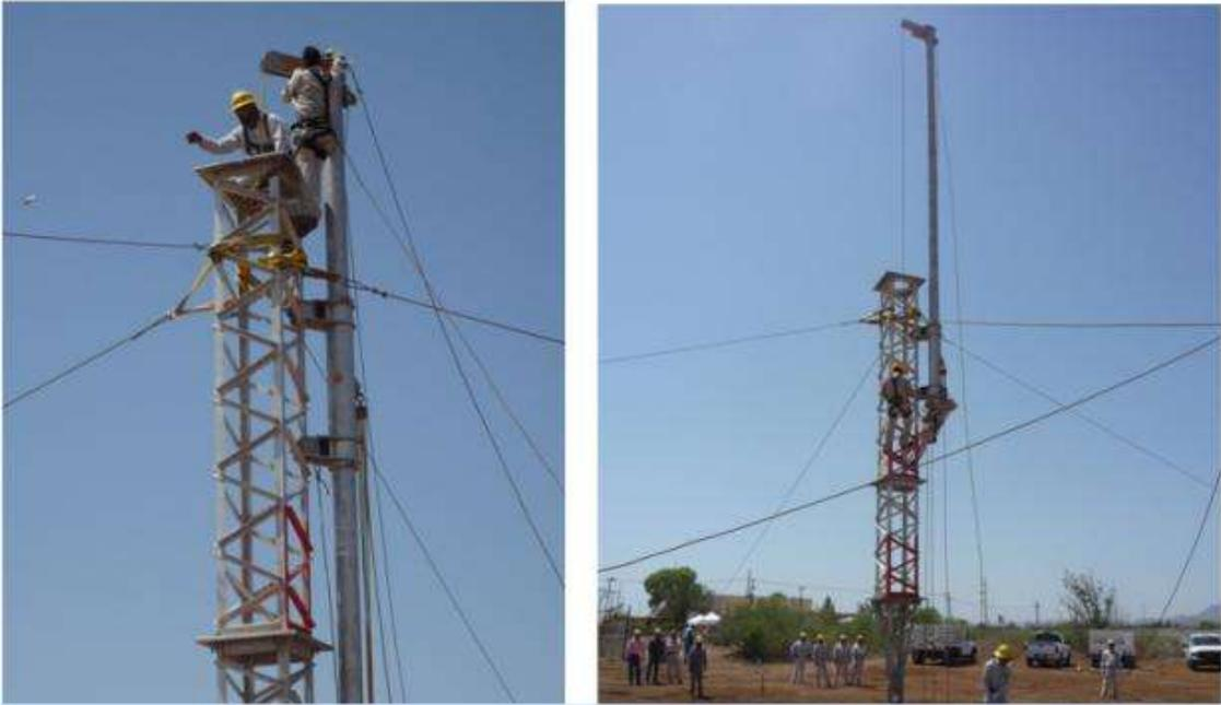
**Figura 57.- Para mantener los primeros módulos se requiere instalar gasas para retenidas provisionales**
