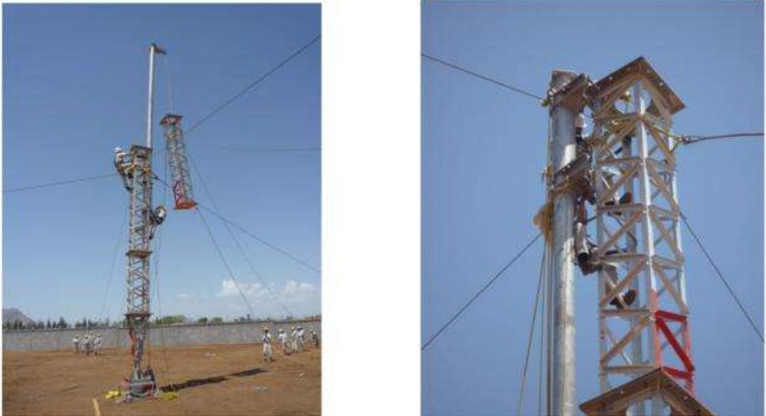
**Figura 58.- Se sube el cañón de la pluma flotante para subir la pluma**
