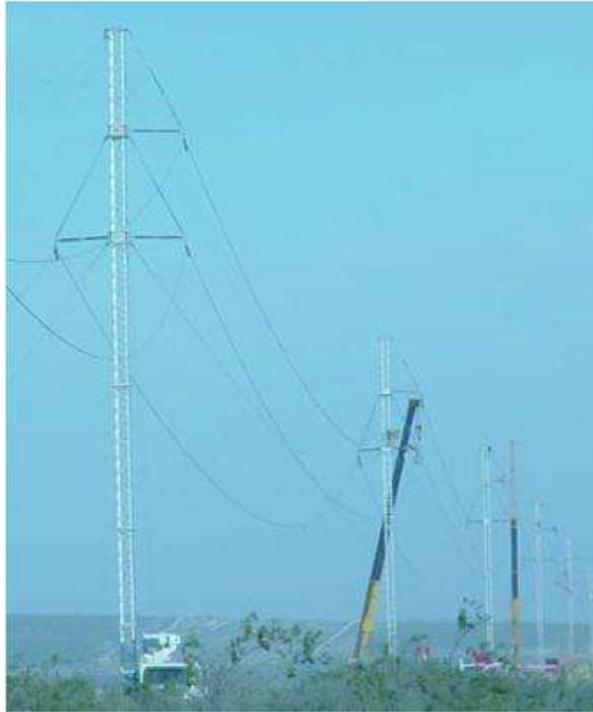
Figura 30.- Arreglo tipo delta
