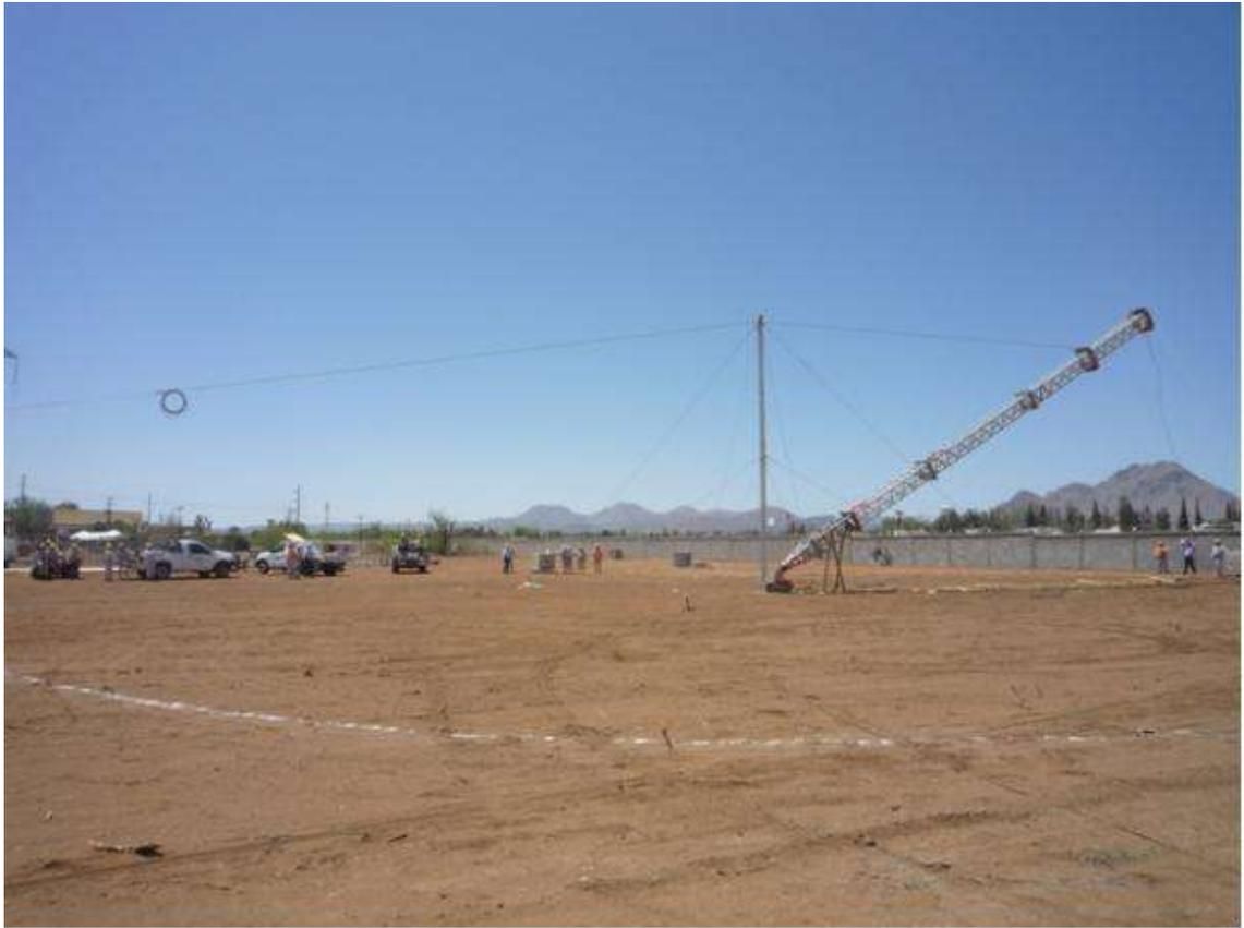
**Figura 48.- Para esta maniobra se requiere trazar un área de seguridad**
