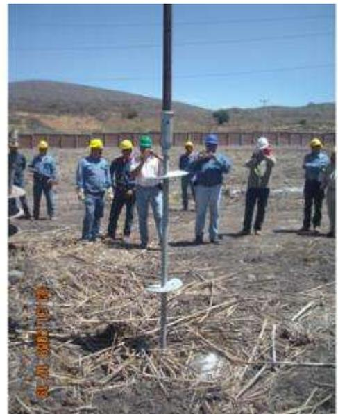
**Figura 42.- Instalando anclaje tipo helicoidal**
