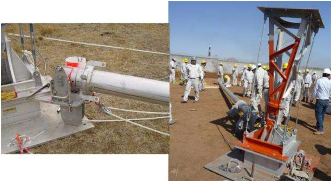
**Figura 54.- Pluma deslizante instalada en una de las esquinas de la base de la columna**
