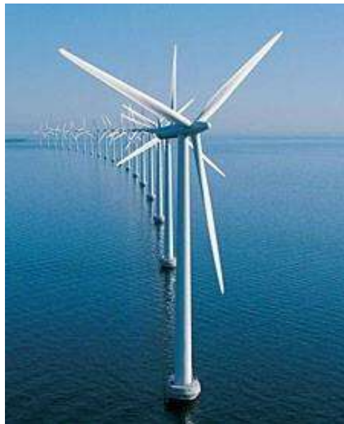
Figura 3.8. Aerogenerador Tipo Tripala
