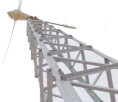
Figura 3.12. Aerogenerador Tipo Torre de Celosía
