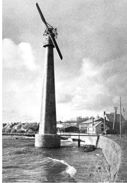
Figura 3.9. Aerogenerador Tipo Bipala
