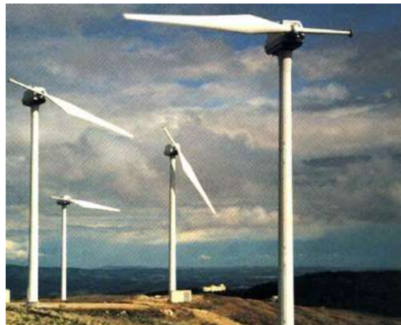
Figura 3.10. Aerogenerador Tipo Monopala
