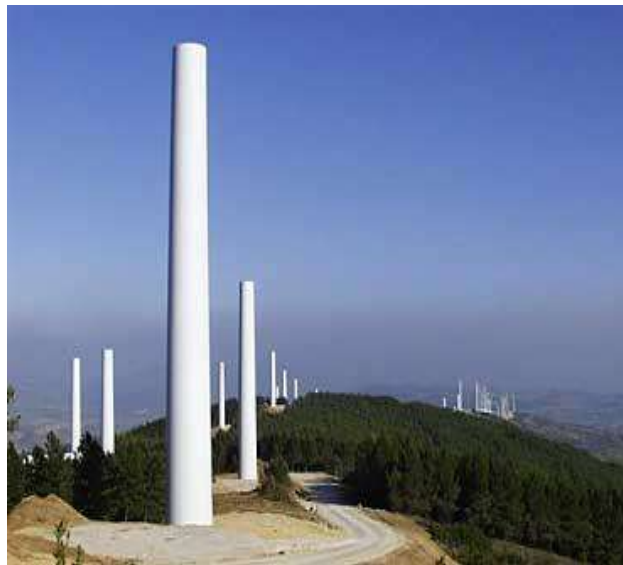
Figura 3.13. Aerogenerador Tipo Torre Tubular
