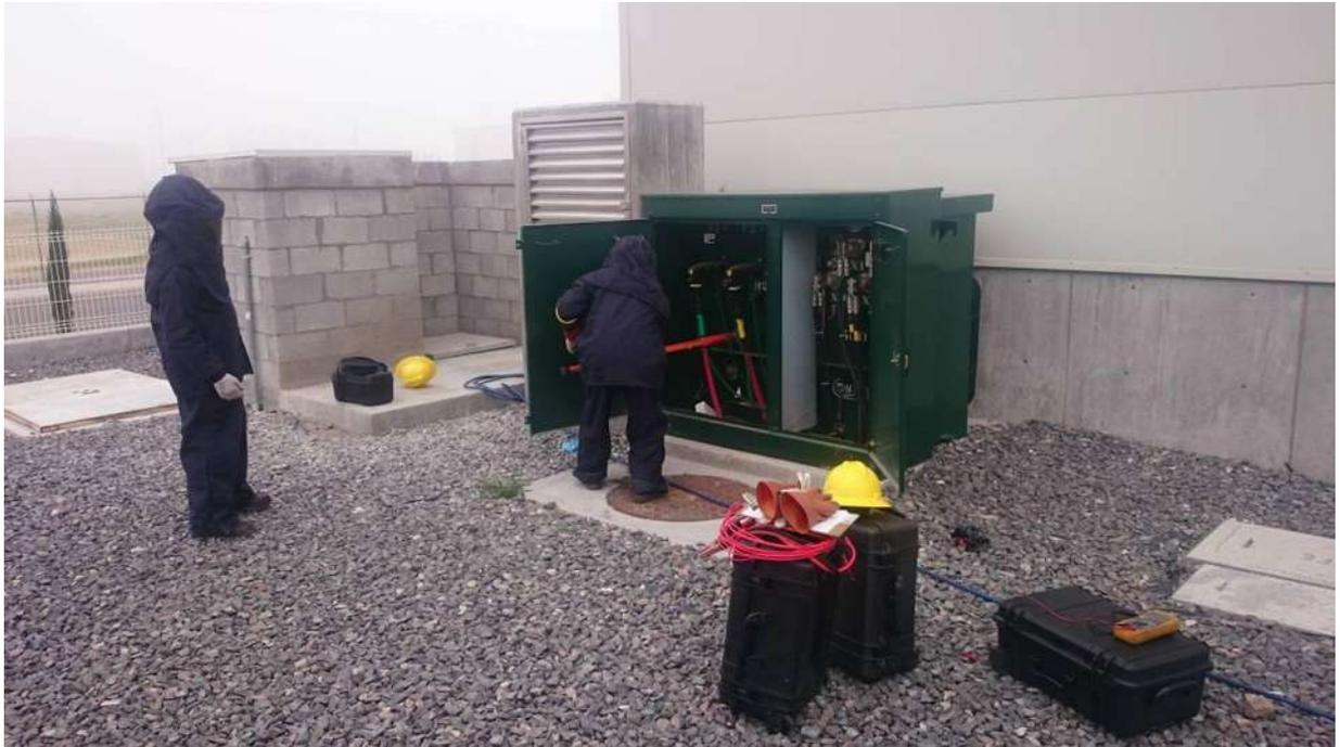
**Figura 32.-** Desconexión de sub estación con pértiga tipo escopeta.
