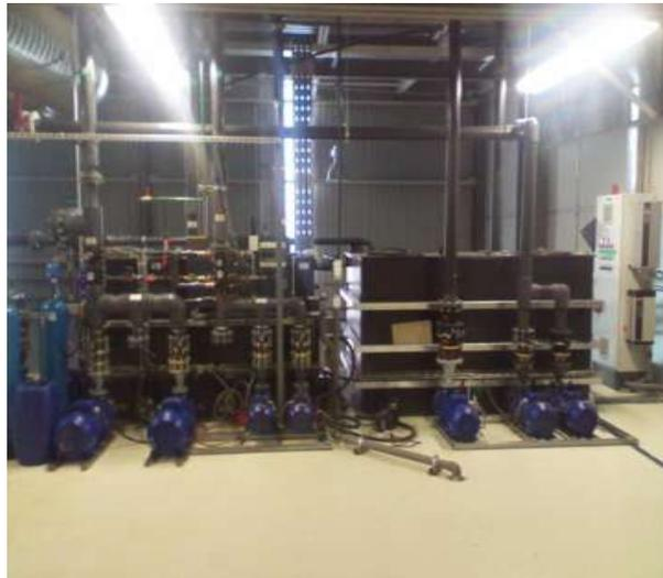
**Figura 25.- Ensamble y conexión de sistema enfriamiento de agua lado derecho, proceso 17°C, lado izquierdo, proceso 27°C.**
