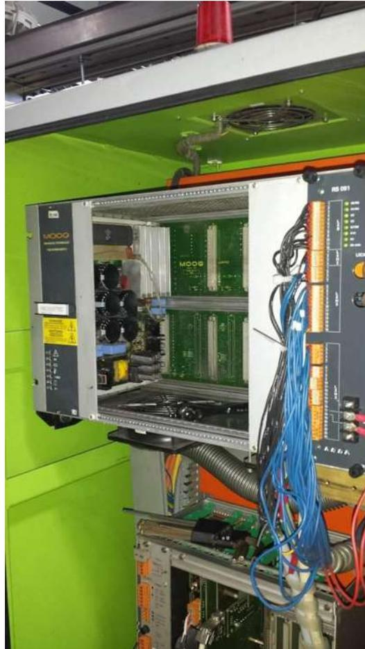
**Figura 35.- Limpieza y ordenamiento de tablero robot RC90 ENGEL**
