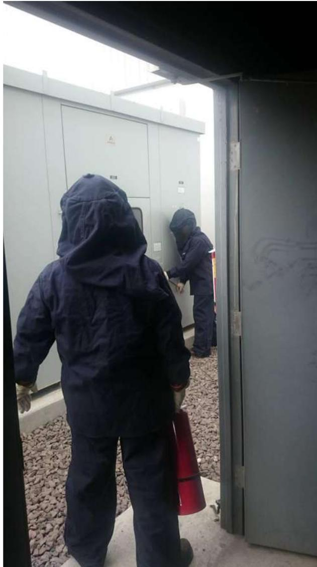
***Figura 31.- Ingreso a desconexión de sub estación con EPP y extinguidor de PQS***
