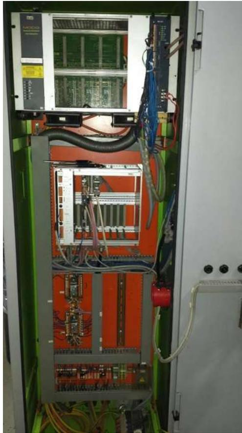
*Figura 36.- Tablero después de colocar el panduit y retirar los servodrive*
