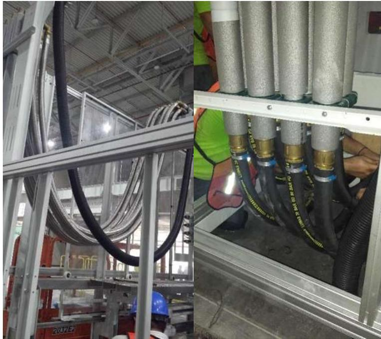
**Figura 73.-** *Instalación de circuitos de refrigeración.*
