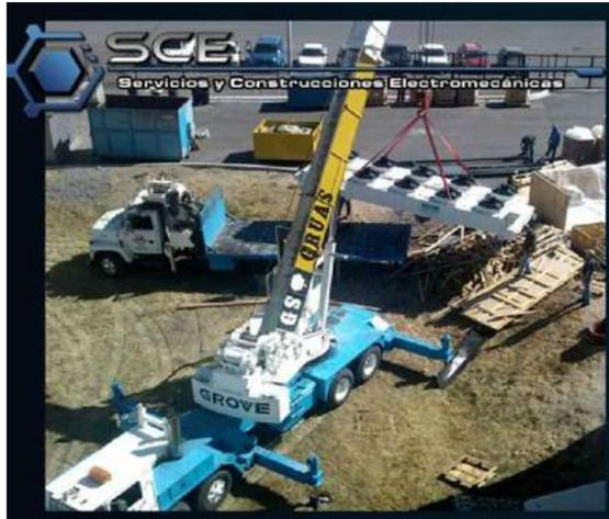
**Figura 24.- Descarga de chiller con grúa de 60 ton.<sup>19</sup>**
