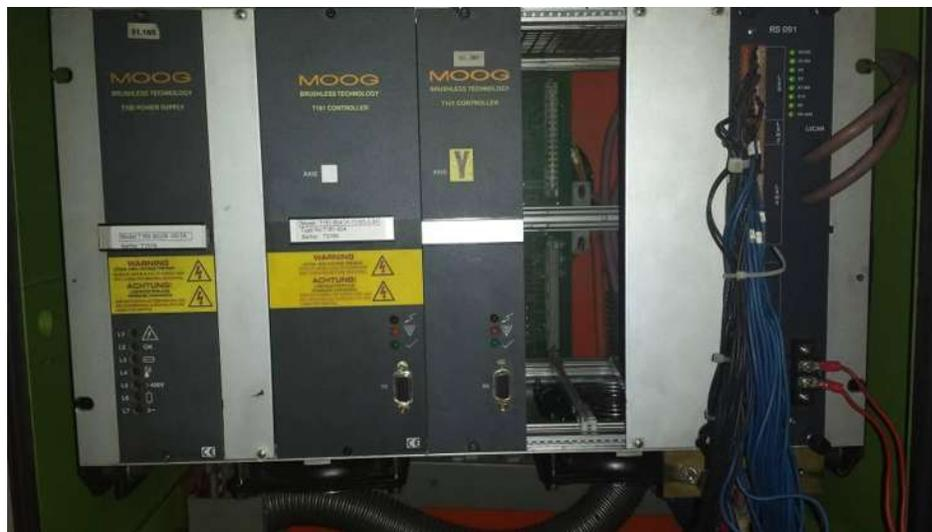
*Figura 39.- Colocación de servodrivres moog.*
