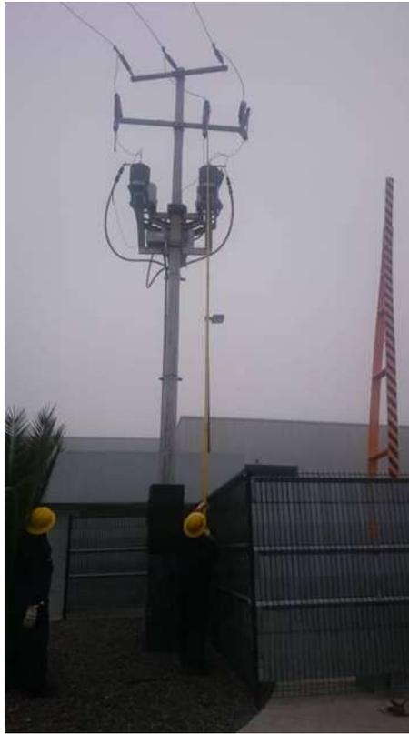
**Figura 30.- Desconexión de alimentadores principales para mantenimiento anual de sub estación**
