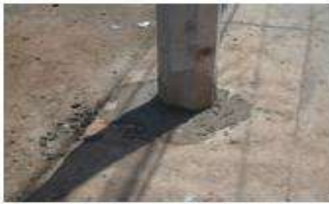
RESANE DE BANQUETA EN POSTE
