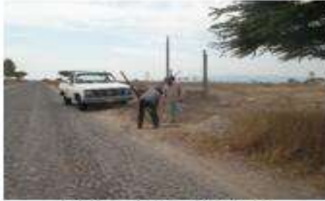
EXCAVACION DE CEPAS
