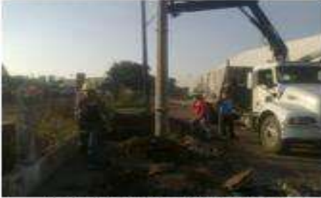
INSTALACION DE POSTES
