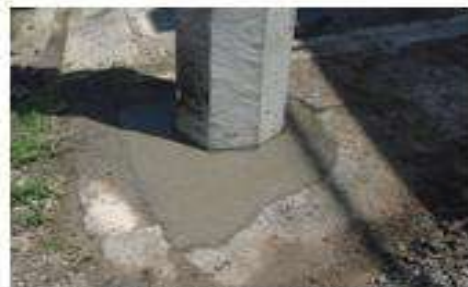
RESANE DE BANQUETA EN POSTE
