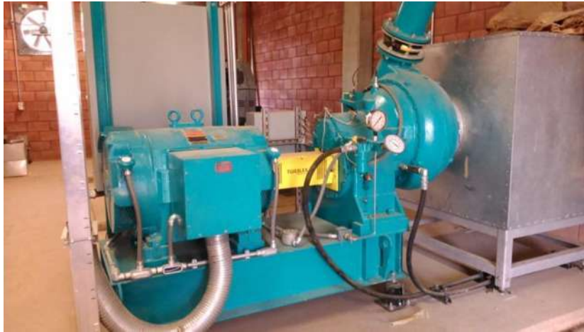
Figura 17.- Motor Soplador Turblex
