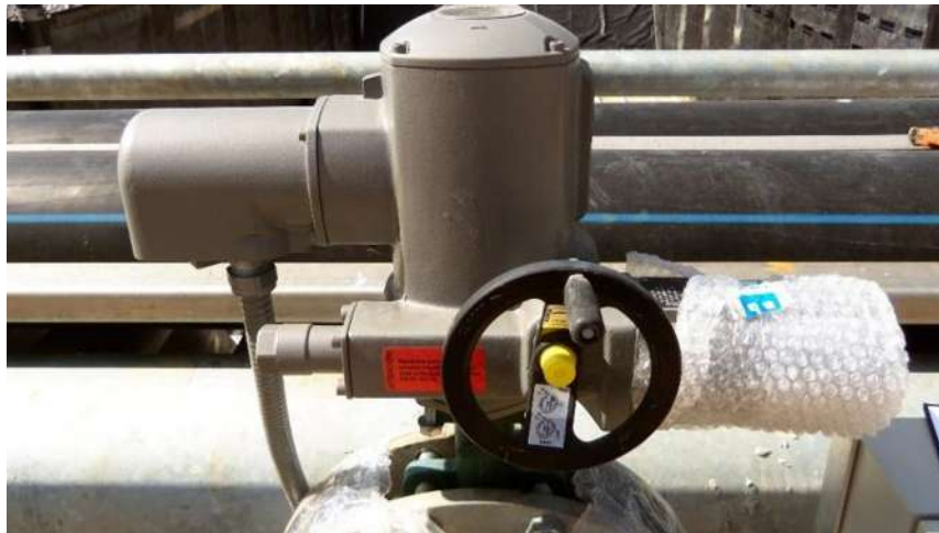
Figura 38.- Válvula Automática AUMA
