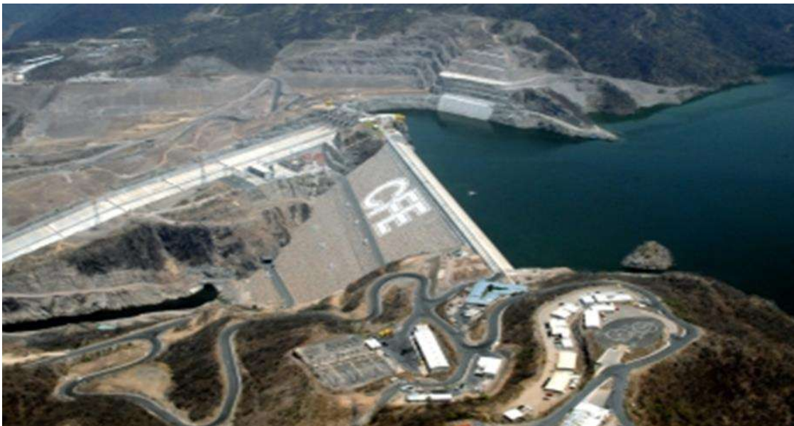
Figura 2.7 Central hidroeléctrica “El Cajón”, Nayarit, México.
