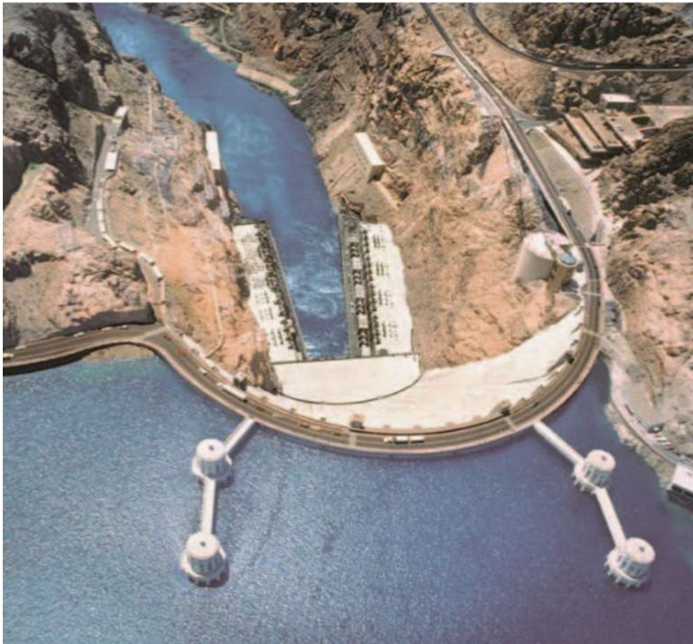
Figura 2.10 Vista aérea de la presa “Hoover”, Nevada, construido entre 1931 y 1936 [6].
