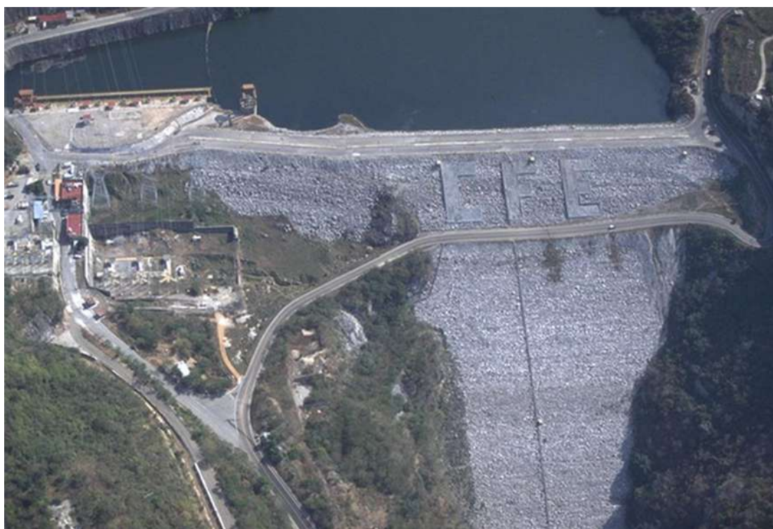
Figura 2.6 Central hidroeléctrica “Chicoasen”, Chiapas.
