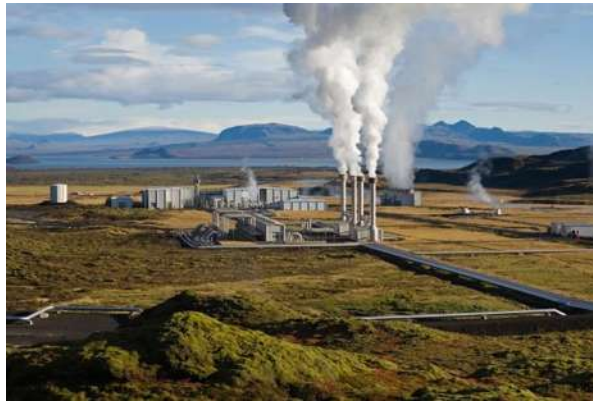
Figura 2.25 Vista de una planta geotermoeléctrica
