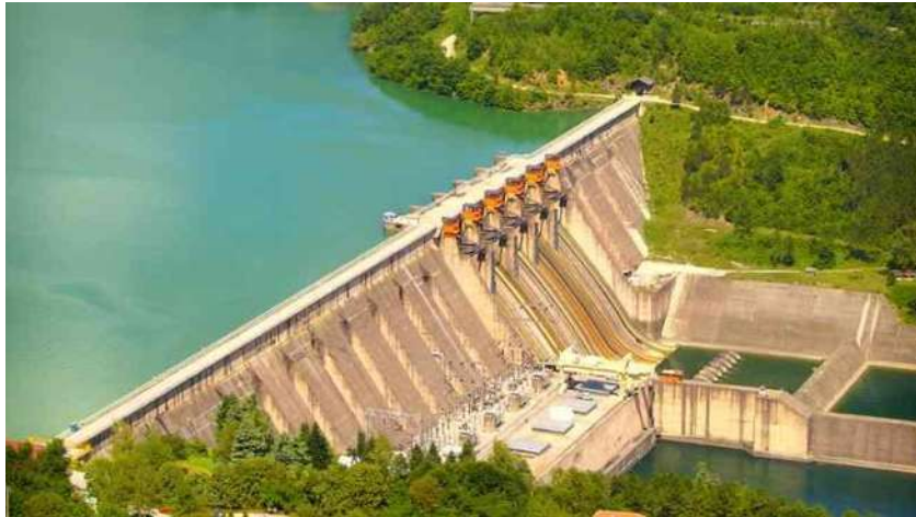
Figura 2.19 Vista de una central hidroeléctrica
