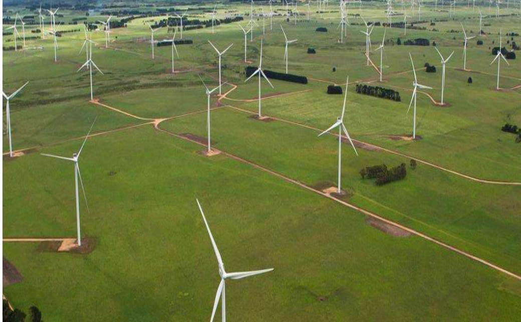
Figura 2. 7 Parque Eólico en México [24]
