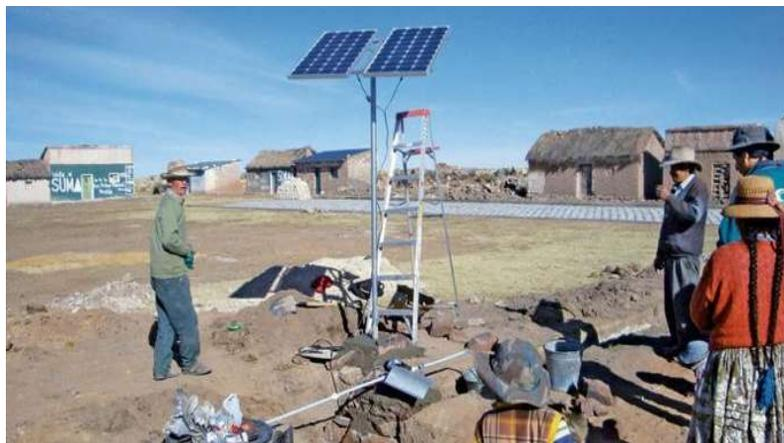
**Figura 3. 10 Sistema de bombeo fotovoltaico aplicado a consumo humano**
